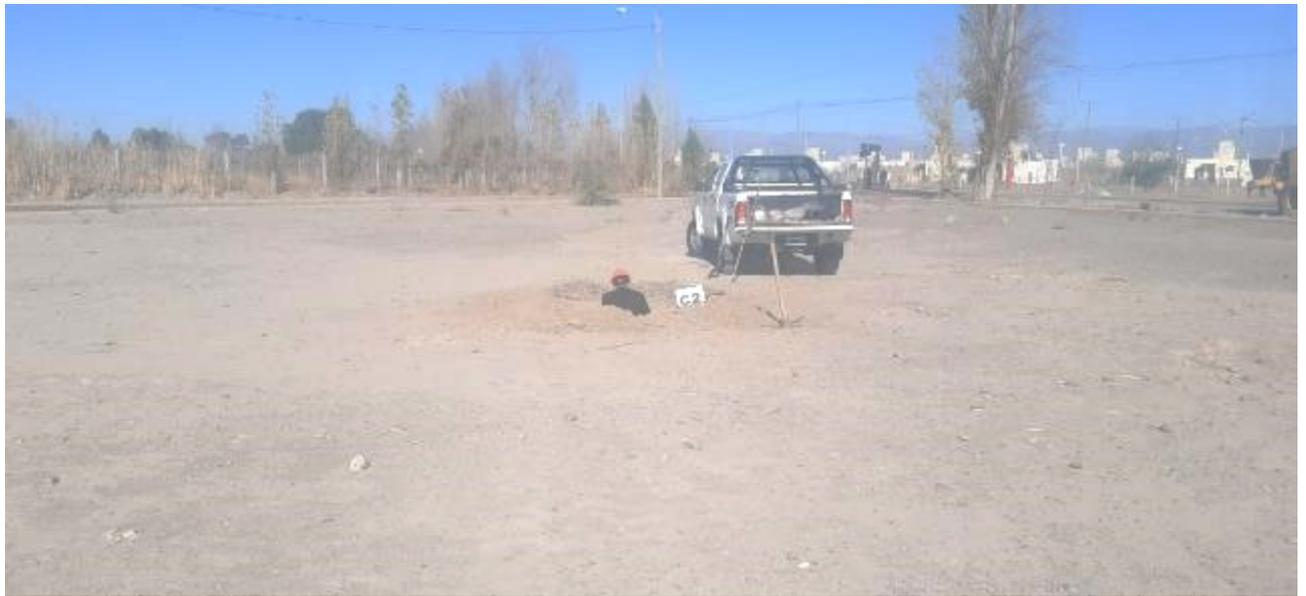
**Fotografía N°8:** Vista de la posición en el terreno de la Calicata **C.2**. Se observan los trabajos de excavación y toma de muestra.
