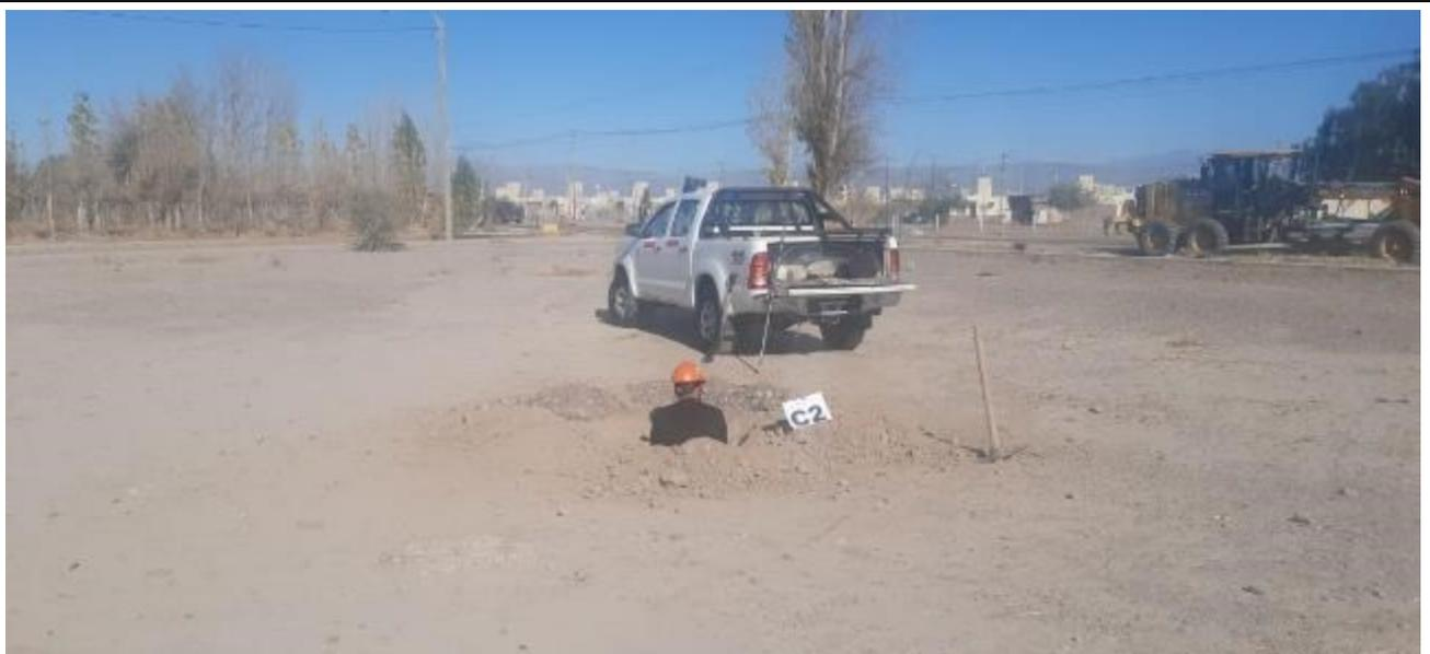
**Fotografía N°9:** Vista de la posición en el terreno de la Calicata **C.2**. Se observan los trabajos de excavación y toma de muestra.
