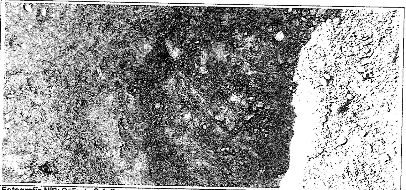
**Fotografía N°3:** Calicata C.1. Se muestra el perfil estratigráfico de suelos formado por una grava limo-arenosa que forma parte del paquete estructural vial de la RP12, con un espesor de 0,70m, y subyacente aflora el manto rocoso.
