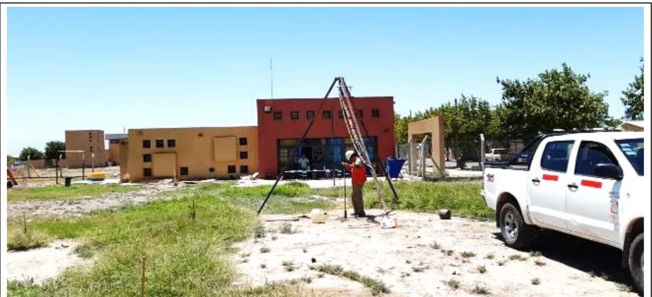
**Fotografía N°8:** Vista de la posición en el terreno del Sondeo **S.2**. Se observan los trabajos de perforación y toma de muestra, como así también el ensayo de penetración estándar (SPT).
