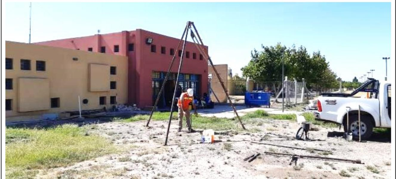
**Fotografía N°5:** Vista de la posición en el terreno del Sondeo **S.1**. Se observan los trabajos de perforación y toma de muestra, como así también el ensayo de penetración estándar (SPT).
