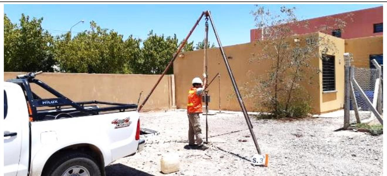
**Fotografía N°14:** Vista de la posición en el terreno del Sondeo **S.3**. Se observan los trabajos de perforación y toma de muestra, como así también el ensayo de penetración estándar (SPT).
