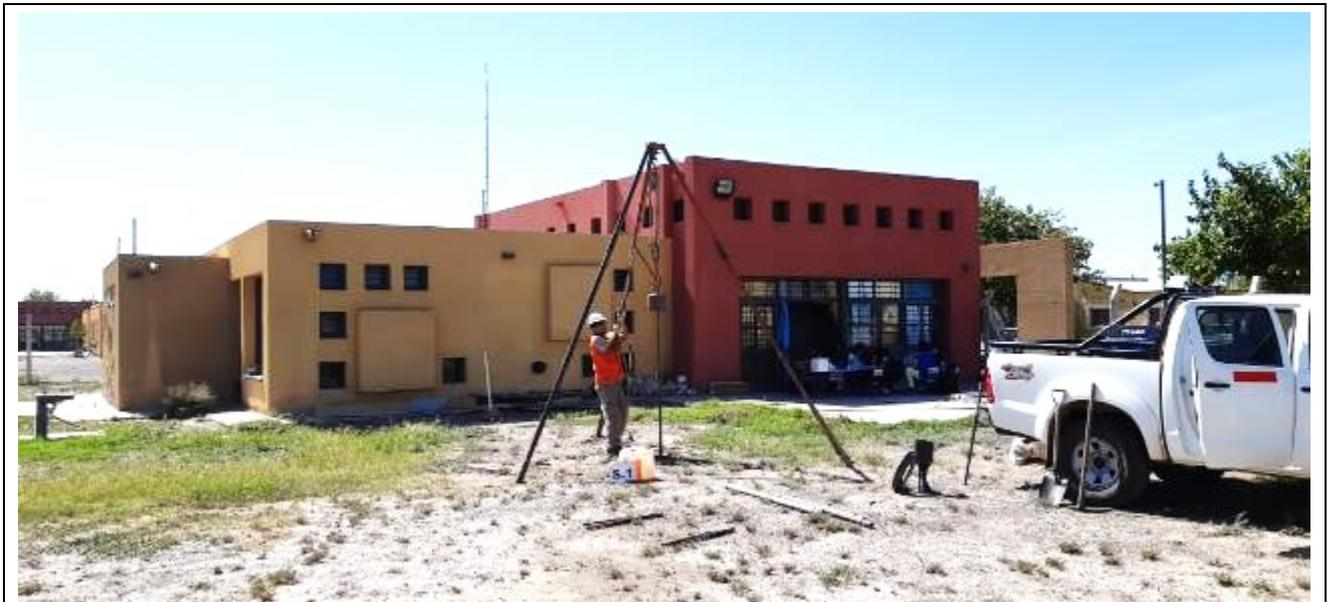
**Fotografía N°6:** Vista de la posición en el terreno del Sondeo **S.1**. Se observan los trabajos de perforación y toma de muestra, como así también el ensayo de penetración estándar (SPT).
