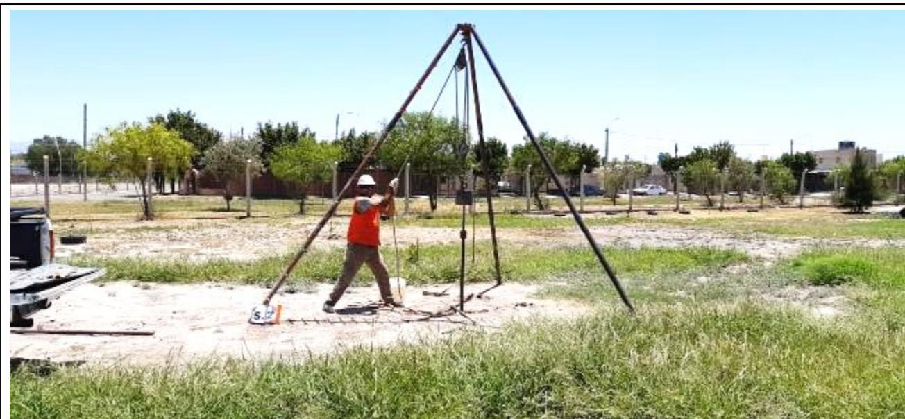
**Fotografía N°10:** Vista de la posición en el terreno del Sondeo **S.2**. Se observan los trabajos de perforación y toma de muestra, como así también el ensayo de penetración estándar (SPT).
