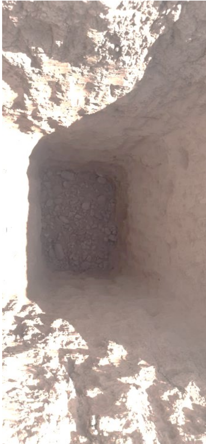
Fotografía N°14: Calicata C.3 . Se muestra el perfil estratigráfico de suelos formado por un estrato superior de limo arenoso de 1,30m de espesor, y subyacente aparece el estrato granular grueso del cono aluvial del Río San Juan formado por una grava arenosa.
