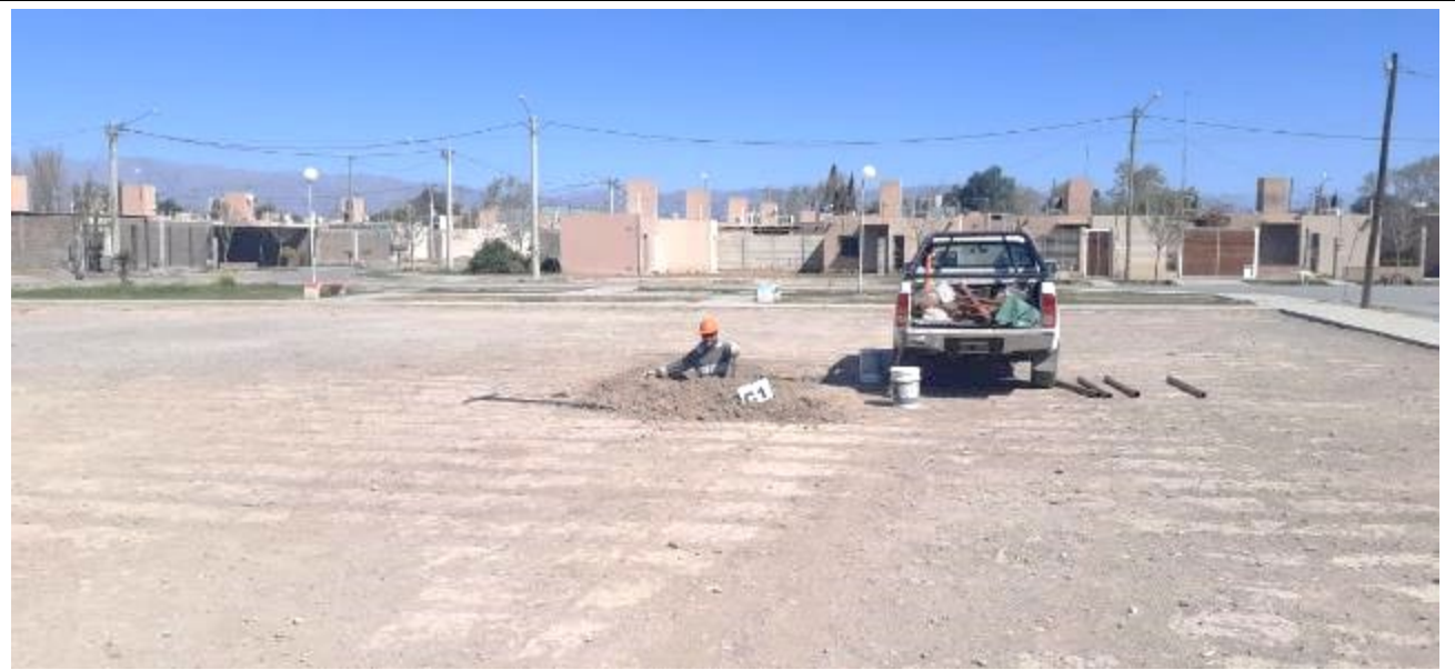
Fotografía N°1: Vista de la posición en el terreno de la Calicata C.1. Se observan los trabajos de excavación y toma de muestra.
