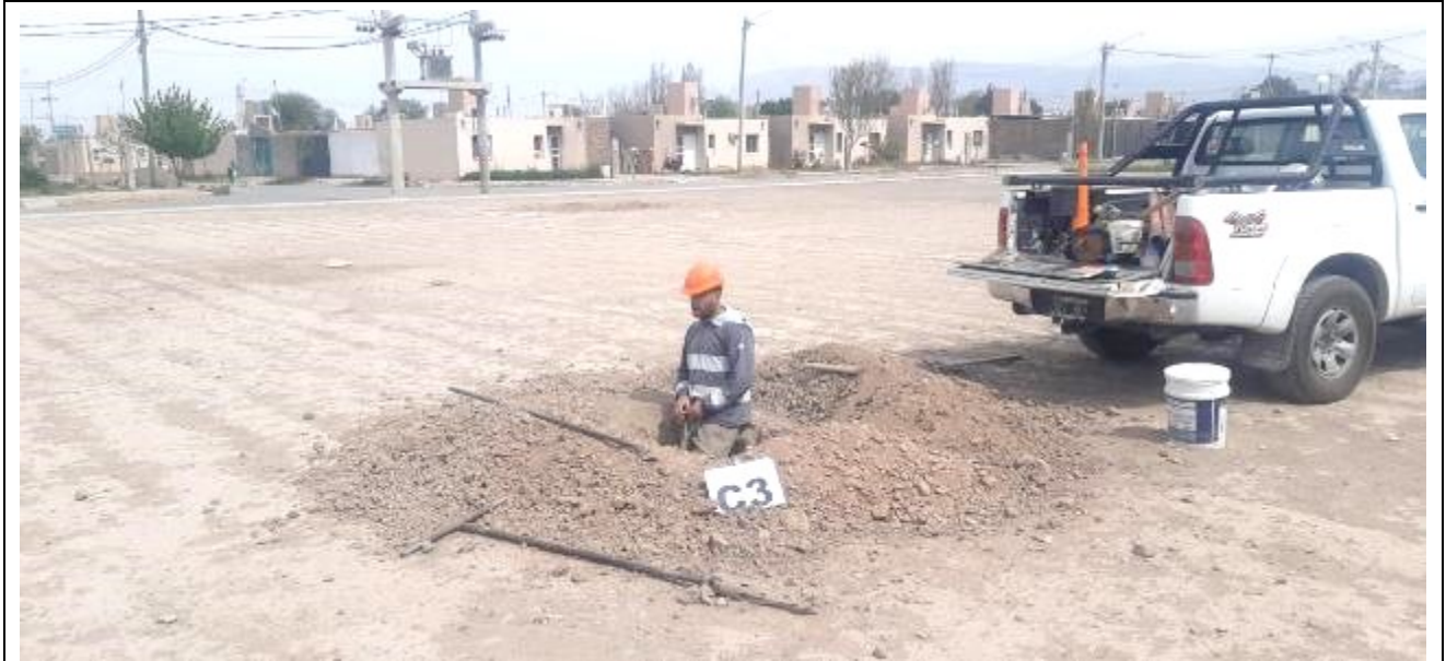
Fotografía N°12: Vista de la posición en el terreno de la Calicata C.3 . Se observan los trabajos de excavación y toma de muestra.
