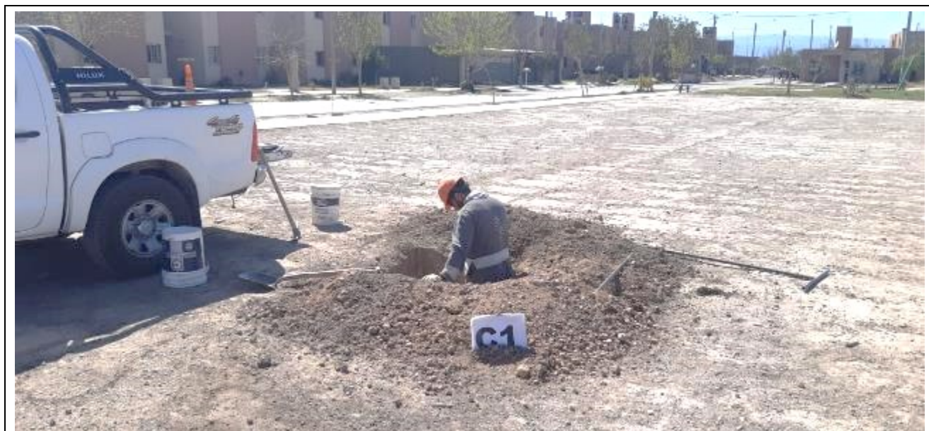
Fotografía N°3: Vista de la posición en el terreno de la Calicata C.1. Se observan los trabajos de excavación y toma de muestra.
