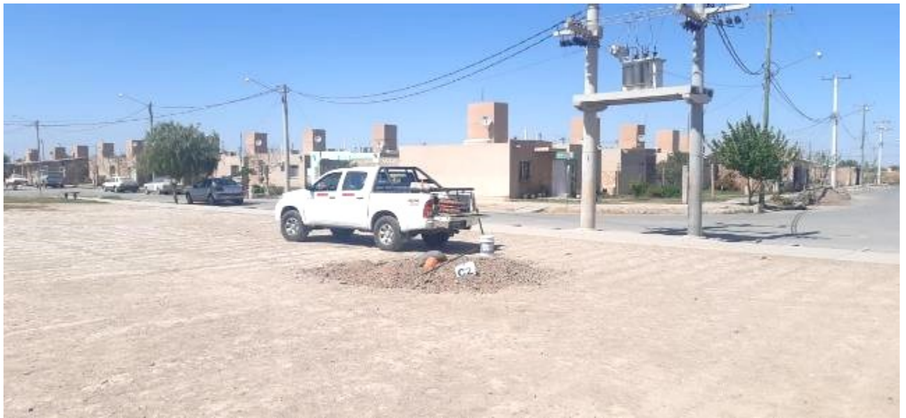
Fotografía N°6: Vista de la posición en el terreno de la Calicata C.2. Se observan los trabajos de excavación y toma de muestra.
