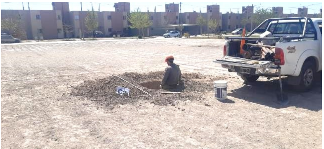
Fotografía N°7: Vista de la posición en el terreno de la Calicata C.2. Se observan los trabajos de excavación y toma de muestra.
