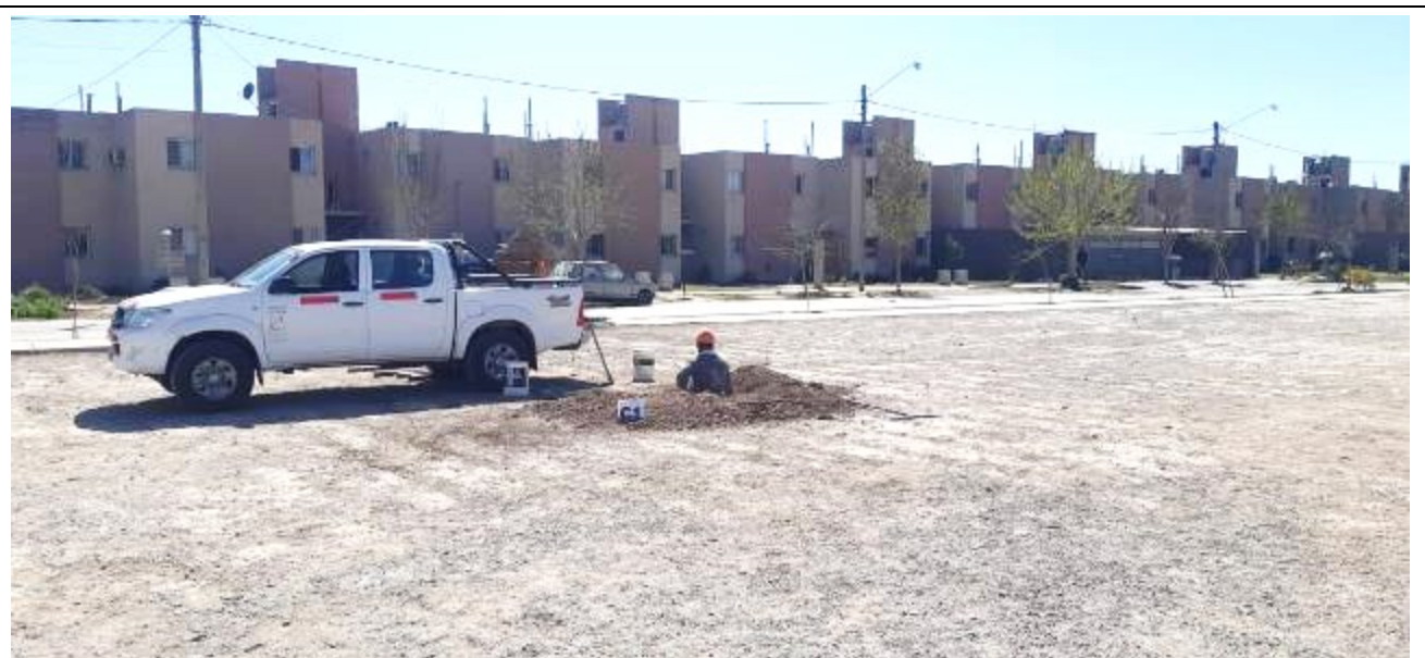
Fotografía N°2: Vista de la posición en el terreno de la Calicata C.1. Se observan los trabajos de excavación y toma de muestra.
