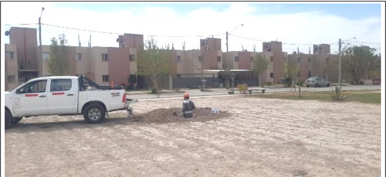
Fotografía N°11: Vista de la posición en el terreno de la Calicata C.3 . Se observan los trabajos de excavación y toma de muestra.
