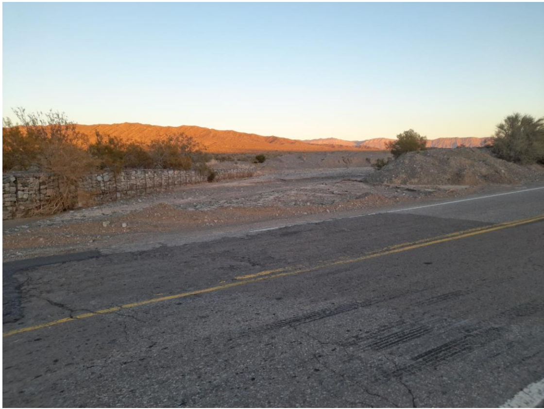
Foto: Badén N°2, aguas arriba – Prog. 1+500.
