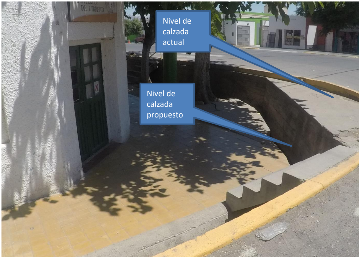
Calle 11, canal actual sobre costado Suroeste (entrada).
