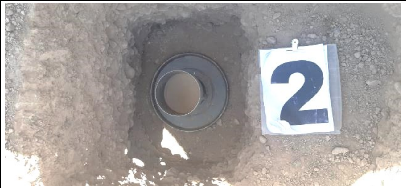
Fotografía N°6: Calicata C.2. Se muestra el ensayo de densidad in situ por el método del cono y la arena (Norma DNV) a la profundidad de 1,10m en el estrato granular grueso formado por una grava arenosa.
