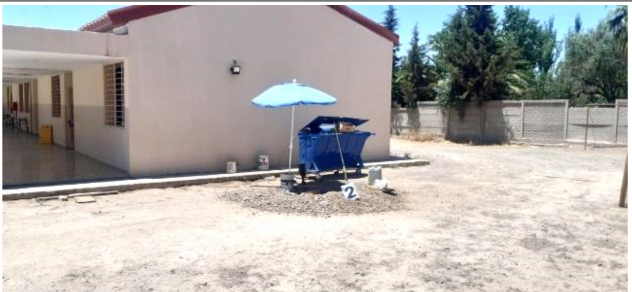
Fotografía N°4: Vista de la posición en el terreno de la Calicata C.2. Se observan los trabajos de excavación y toma de muestra.
