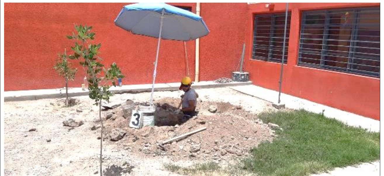
Fotografía N°8: Vista de la posición en el terreno de la Calicata C3 . Se observan los trabajos de excavación y toma de muestra.
