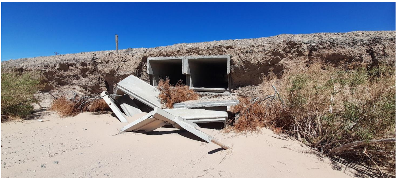
Alcantarilla Prog. 17+800- RECONSTRUCCION DE ALCANTARILLAS
