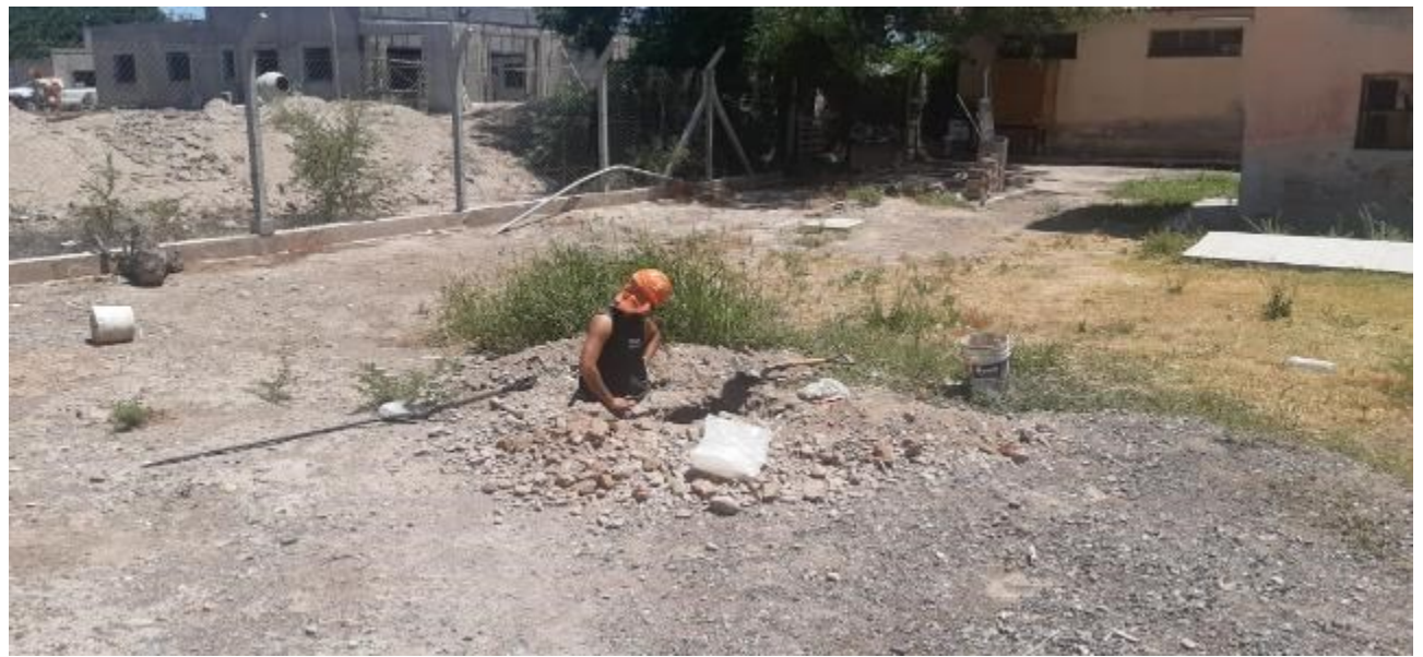
Fotografía N°13: Vista de la posición en el terreno de la Calicata C.3. Se observan los trabajos de excavación y toma de muestra.
