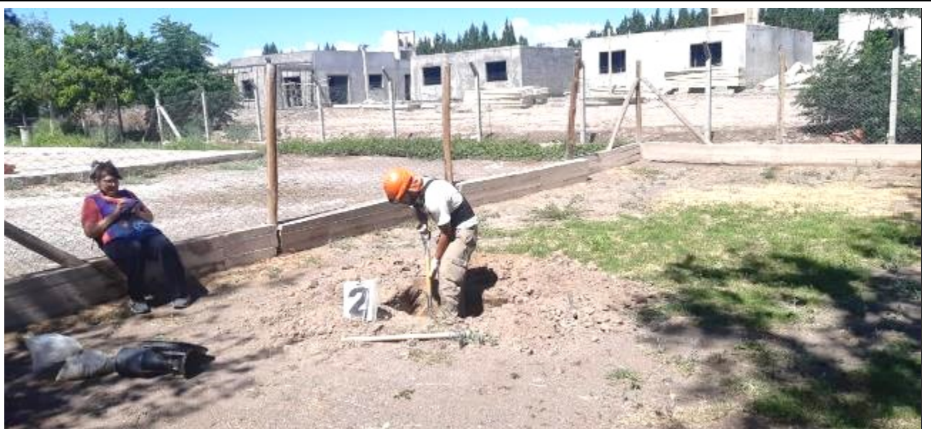
Fotografía N°10: Vista de la posición en el terreno de la Calicata C.2. Se observan los trabajos de excavación y toma de muestra.
