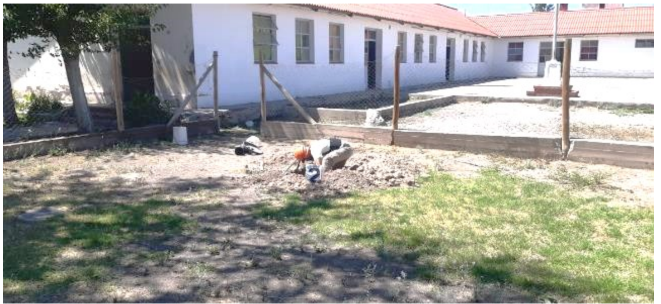
Fotografía N°9: Vista de la posición en el terreno de la Calicata C.2. Se observan los trabajos de excavación y toma de muestra.
