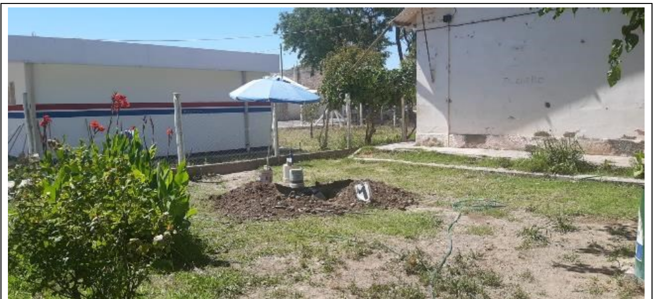
Fotografía N°6: Vista de la posición en el terreno de la Calicata C.1. Se observan los trabajos de excavación y toma de muestra.
