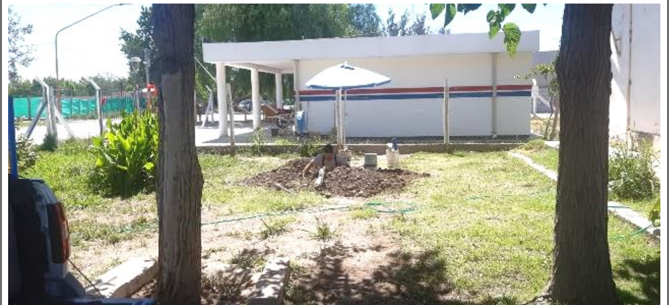
Fotografía N°5: Vista de la posición en el terreno de la Calicata C.1. Se observan los trabajos de excavación y toma de muestra.
