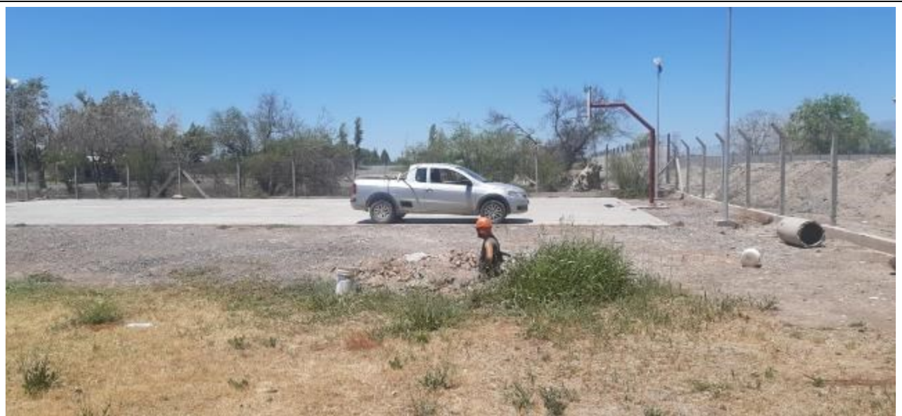
Fotografía N°14: Vista de la posición en el terreno de la Calicata C.3. Se observan los trabajos de excavación y toma de muestra.
