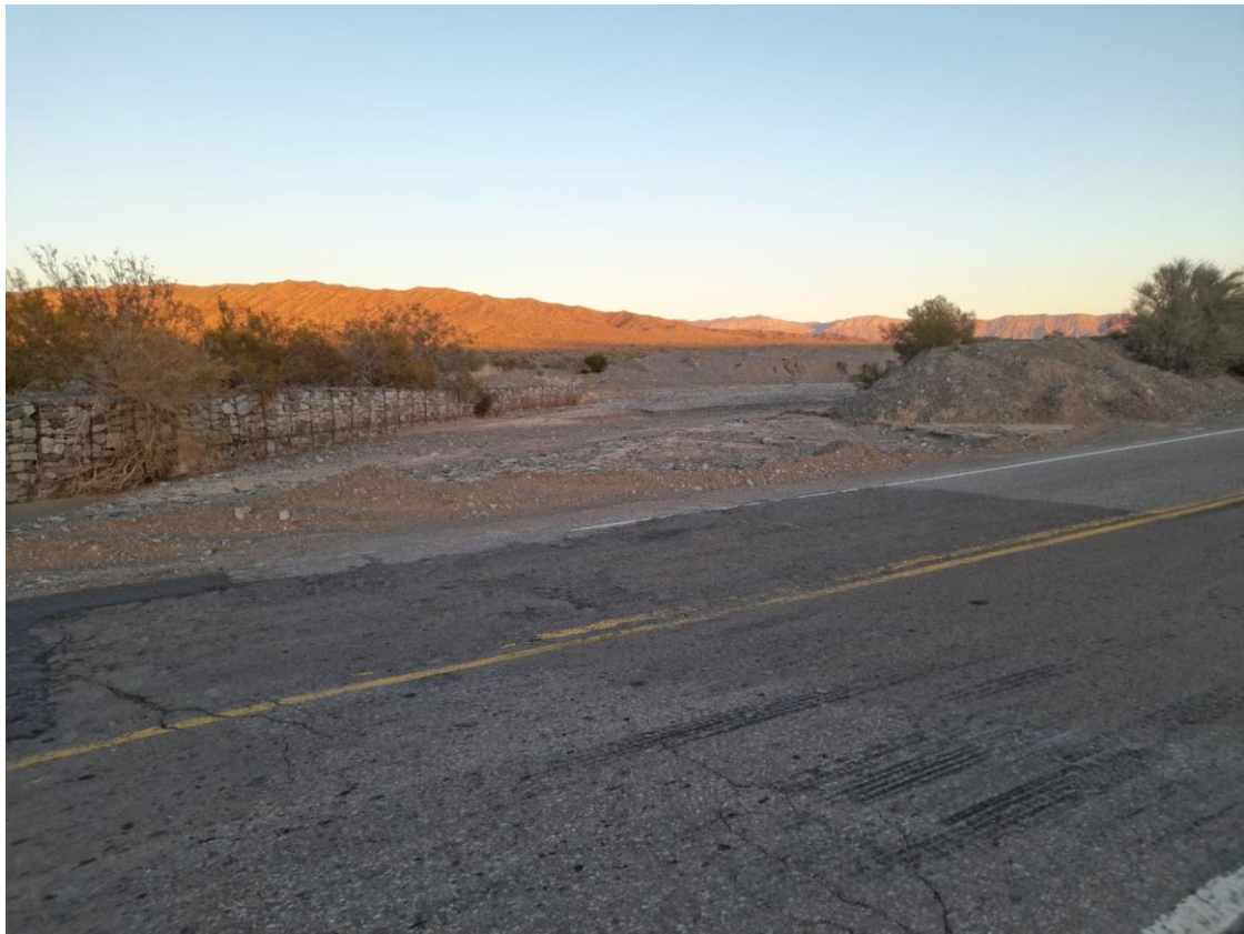
Foto: Badén N°2, aguas arriba – Prog. 1+500.
