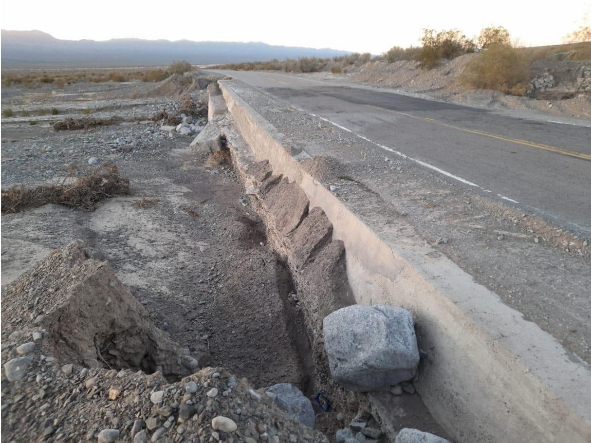
Foto: Badén N°2 – Prog. 1+500.
