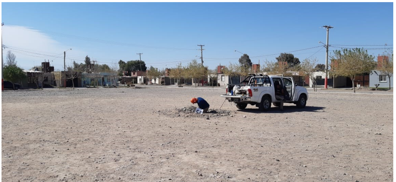
Fotografía N°6: Vista de la posición en el terreno de la Calicata C.1 . Se observan los trabajos de excavación y toma de muestra.
