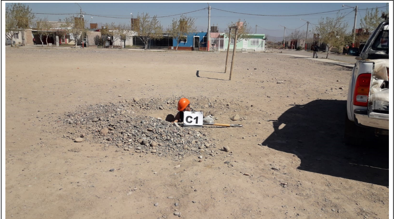
Fotografía N°2: Vista de la posición en el terreno de la Calicata C.1 . Se observan los trabajos de excavación y toma de muestra.
