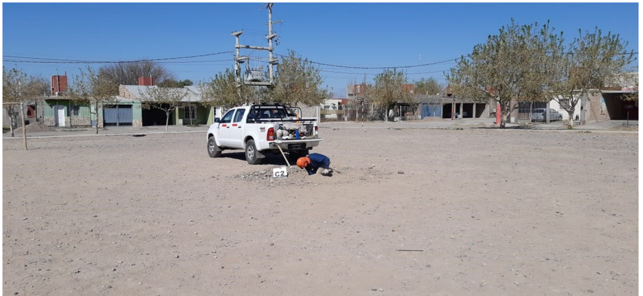
Fotografía N°5: Vista de la posición en el terreno de la Calicata C.1 . Se observan los trabajos de excavación y toma de muestra.
