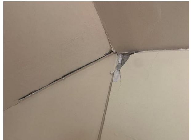
- Desprendimiento de revocos y cielorrasos en Palier de Escalera de Emergencia
