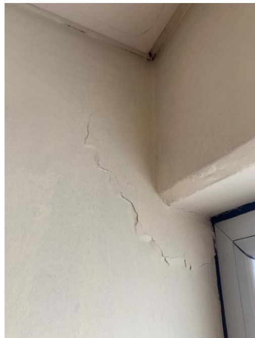
- Desprendimiento de revocos y cielorrasos en Palier de Escalera de Emergencia
