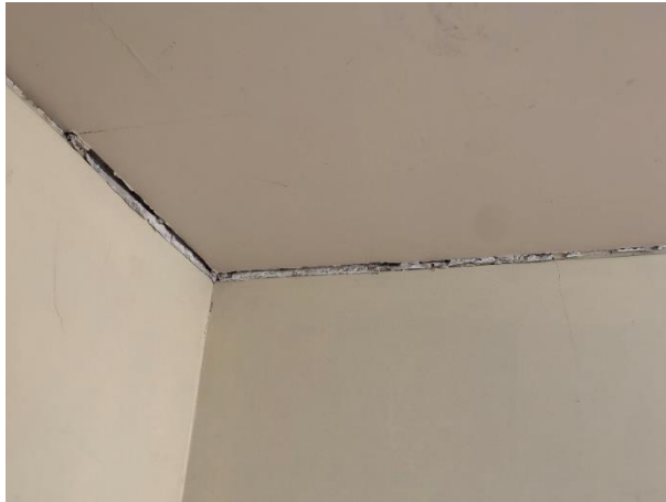
- Desprendimiento de revocos y cielorrasos en Palier de Escalera de Emergencia
