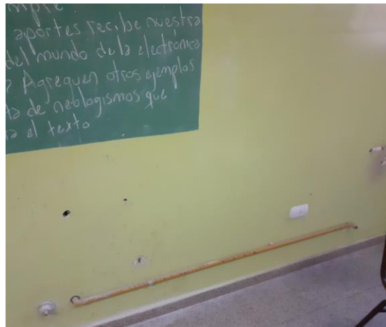
Completar llave de paso, engrampar cañería
