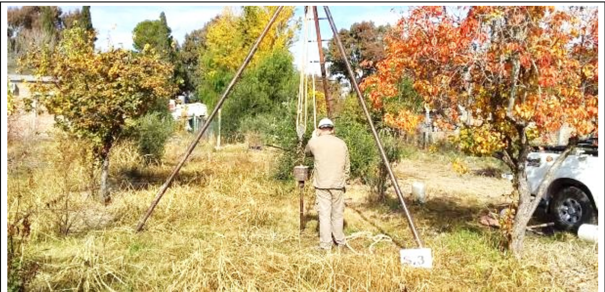
Fotografía N°14: Vista de la posición en el terreno del Sondeo S.3 . Se observan los trabajos de perforación y toma de muestra, como así también el ensayo de penetración estándar (SPT).
