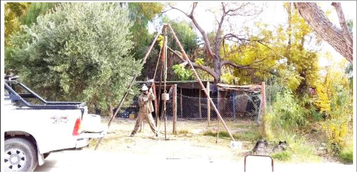
Fotografía N°9: Vista de la posición en el terreno del Sondeo S.1. Se observan los trabajos de perforación y toma de muestra, como así también el ensayo de penetración estándar (SPT).
