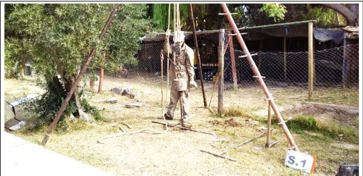
Fotografía N°10: Vista de la posición en el terreno del Sondeo S.1. Se observan los trabajos de perforación y toma de muestra, como así también el ensayo de penetración estándar (SPT).
