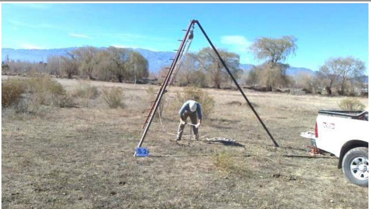
Fotografía N°8: Se muestra una vista de la posición del sondeo S.2 en el terreno estudiado. Se observan los trabajos de excavación y toma de muestra, como así también el ensayo de penetración estándar (SPT).
