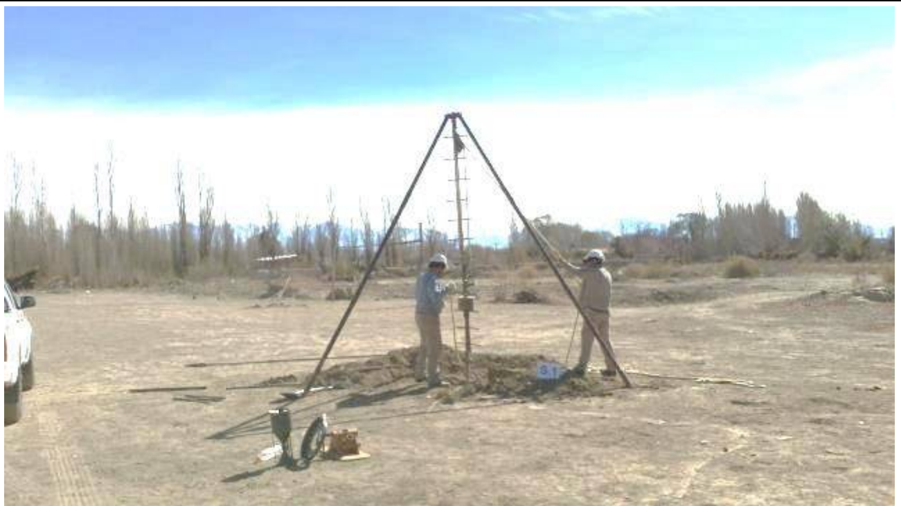
Fotografía N°6: Se muestra una vista de la posición del sondeo S.1 en el terreno estudiado. Se observan los trabajos de excavación y toma de muestra, como así también el ensayo de penetración estándar (SPT).
