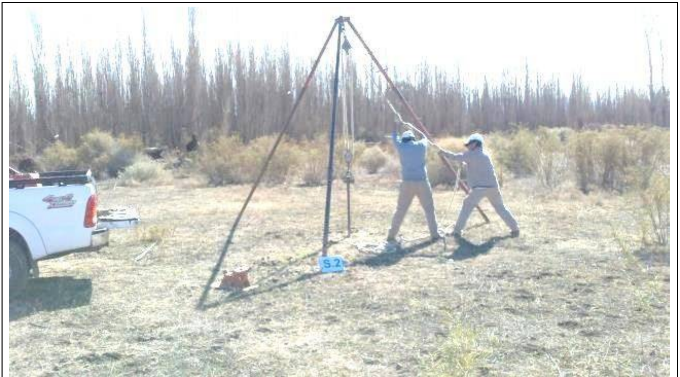
Fotografía N°10: Se muestra una vista de la posición del sondeo S.2 en el terreno estudiado. Se observan los trabajos de excavación y toma de muestra, como así también el ensayo de penetración estándar (SPT).
