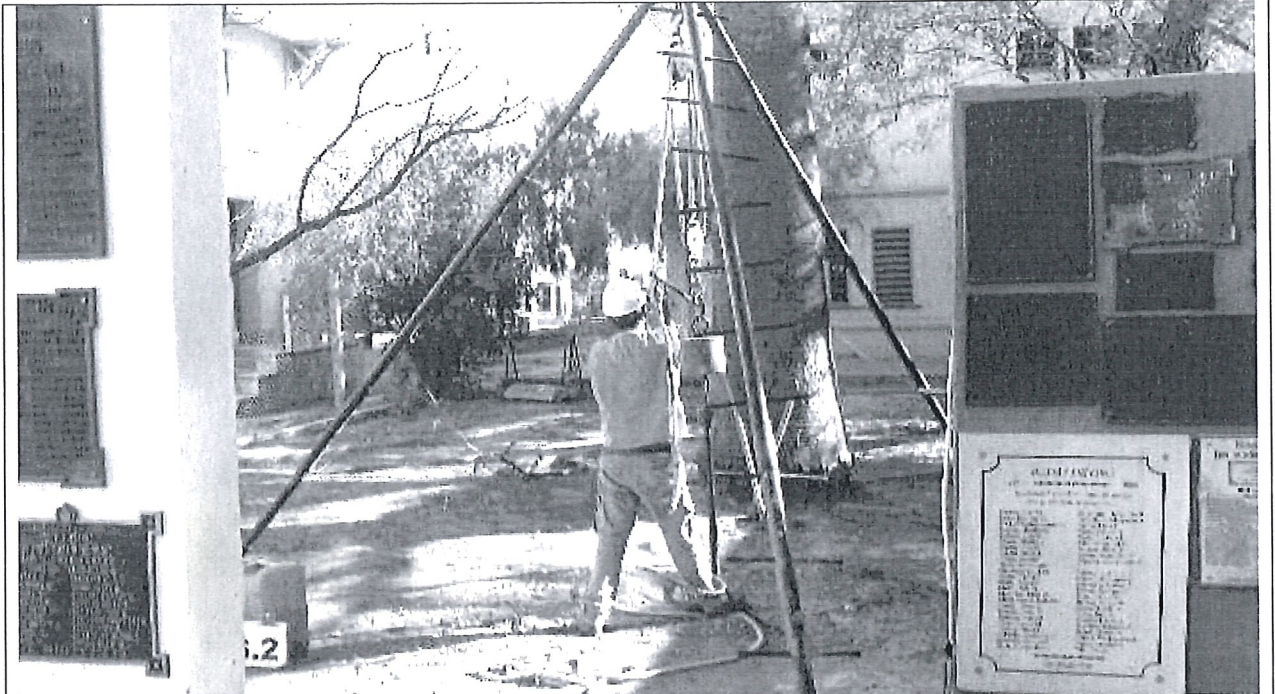
Fotografía N°13: Vista de la posición en el terreno del Sondeo S.2. Se observan los trabajos de perforación y toma de muestra, como así también el ensayo de penetración estándar (SPT).
