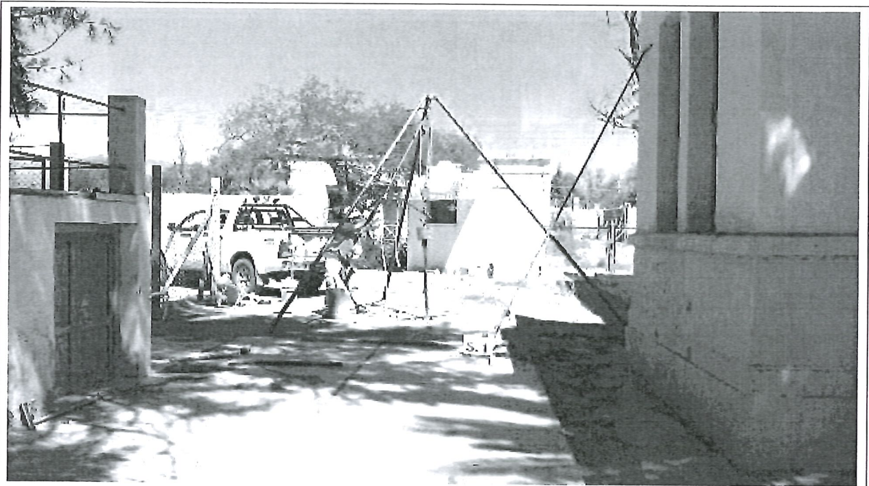
Fotografía N°7: Vista de la posición en el terreno del Sondeo S.1. Se observan los trabajos de perforación y toma de muestra, como así también el ensayo de penetración estándar (SPT).
