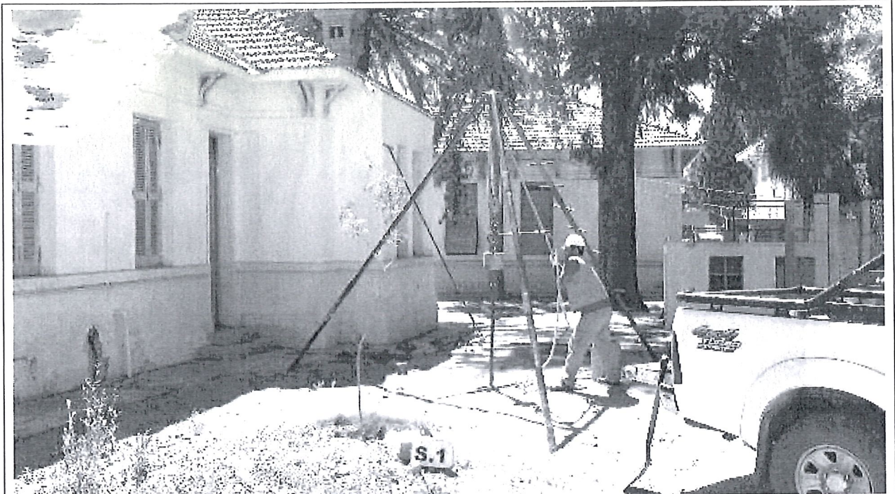
Fotografía N°9: Vista de la posición en el terreno del Sondeo S.1 . Se observan los trabajos de perforación y toma de muestra, como así también el ensayo de penetración estándar (SPT).
