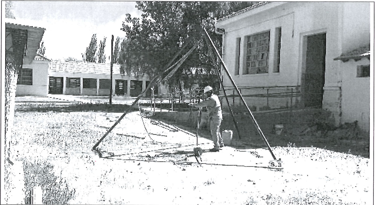
Fotografía N°15: Vista de la posición en el terreno del Sondeo S.3. Se observan los trabajos de perforación y toma de muestra, como así también el ensayo de penetración estándar (SPT).
