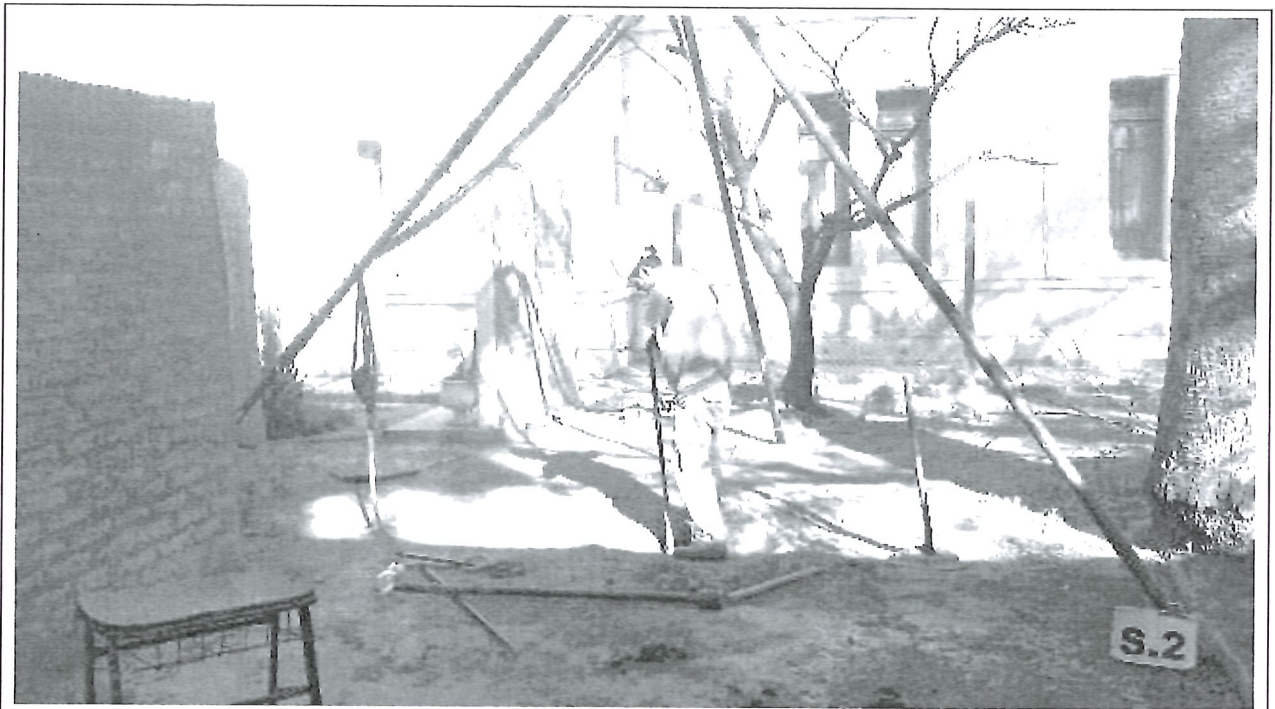
Fotografía N°11: Vista de la posición en el terreno del Sondeo S.2. Se observan los trabajos de perforación y toma de muestra, como así también el ensayo de penetración estándar (SPT).
