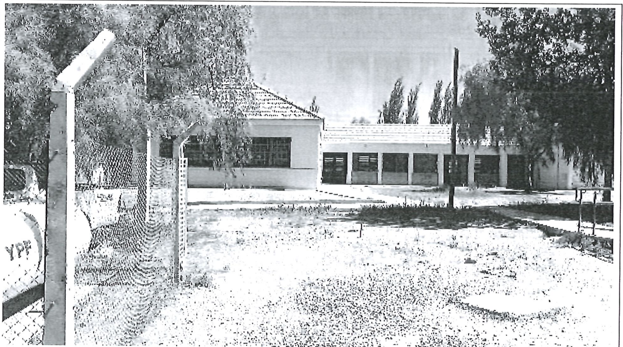
Fotografía N°4: Se muestra una imagen del terreno estudiado perteneciente a la escuela Vélez Sarsfield.
