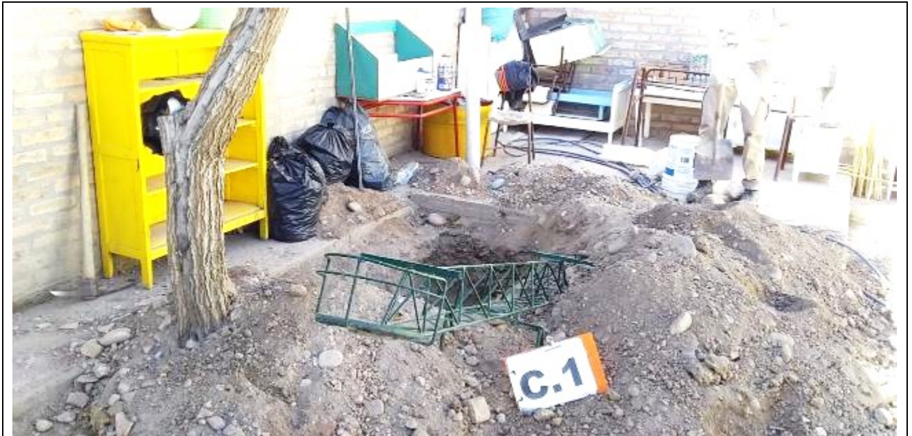
Fotografía N°9: Calicata C.1 . Se muestra la posición de la calicata ejecutada en el terreno estudiado, se observan los trabajos de excavación y toma de muestra.
