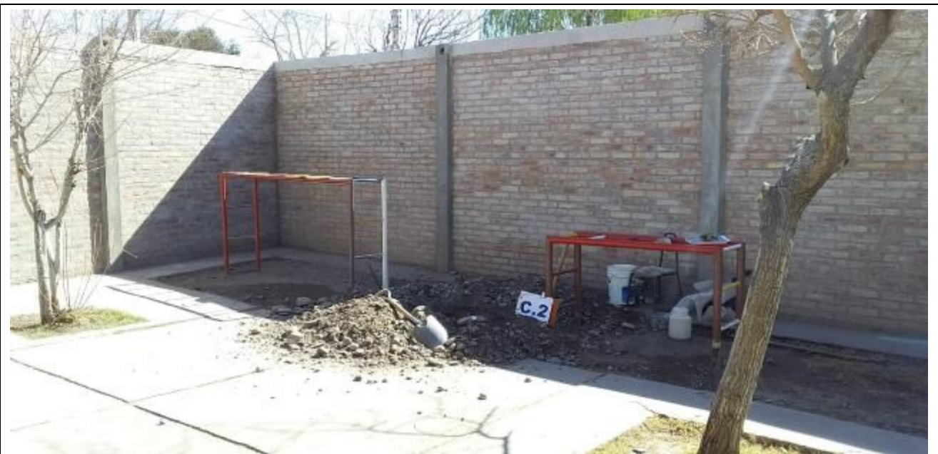
Fotografía N°14: Calicata C.2 . Se muestra la posición de la calicata ejecutada en el terreno estudiado, se observan los trabajos de excavación y toma de muestra.
