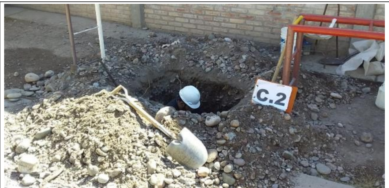
Fotografía N°16: Calicata C.2 . Se muestra la posición de la calicata ejecutada en el terreno estudiado, se observan los trabajos de excavación y toma de muestra.
