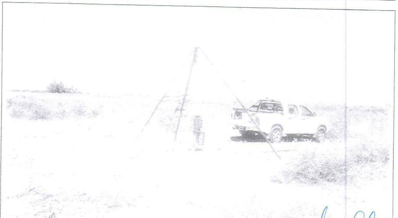
Fotografía N°10: Vista de la posición en el terreno del Sondeo S.2. Se observan los trabajos de perforación y toma de muestra, como así también el ensayo de penetración estándar (SPT).
