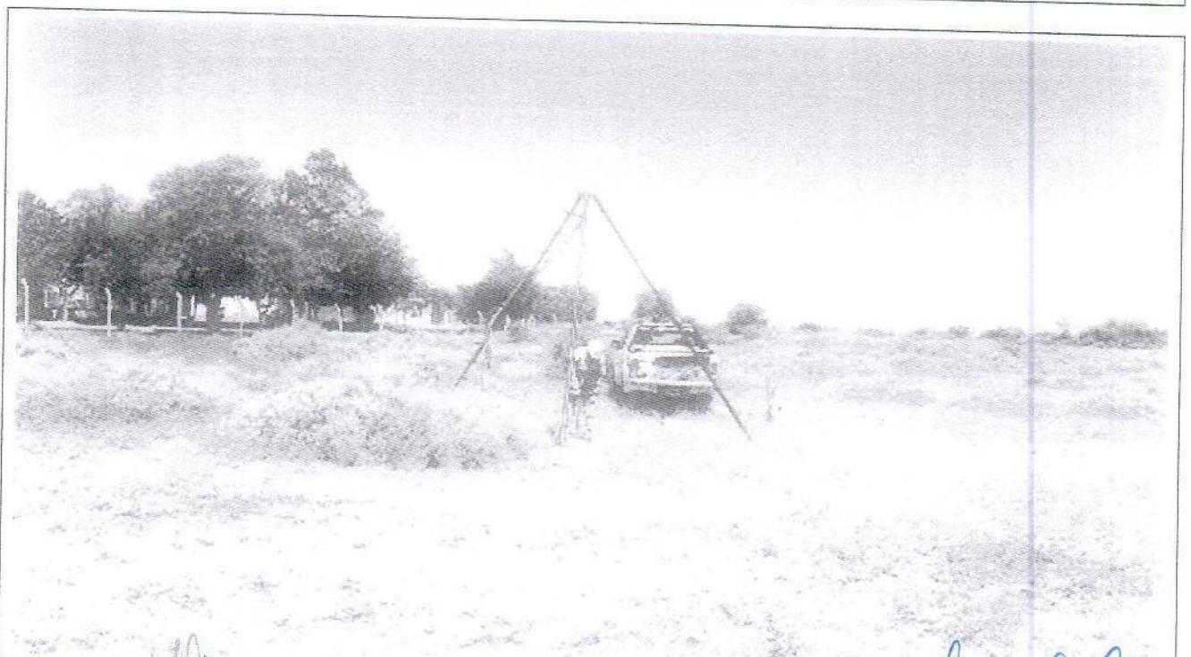
Fotografía N°18: Vista de la posición en el terreno del Sondeo S.4. Se observan los trabajos de perforación y toma de muestra, como así también el ensayo de penetración estándar (SPT).
