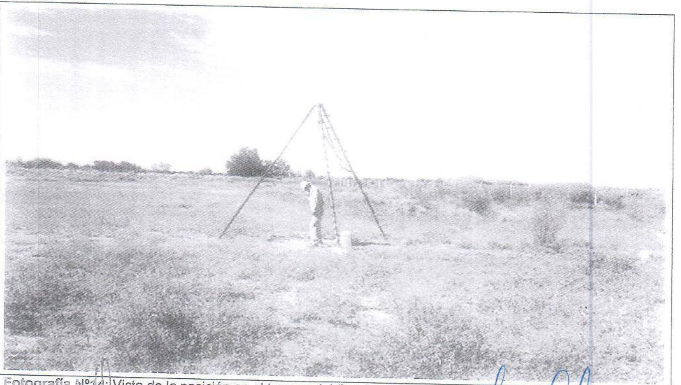
Fotografía N°14: Vista de la posición en el terreno del Sondeo S.3. Se observan los trabajos de perforación y toma de muestra, como así también el ensayo de penetración estándar (SPT).
