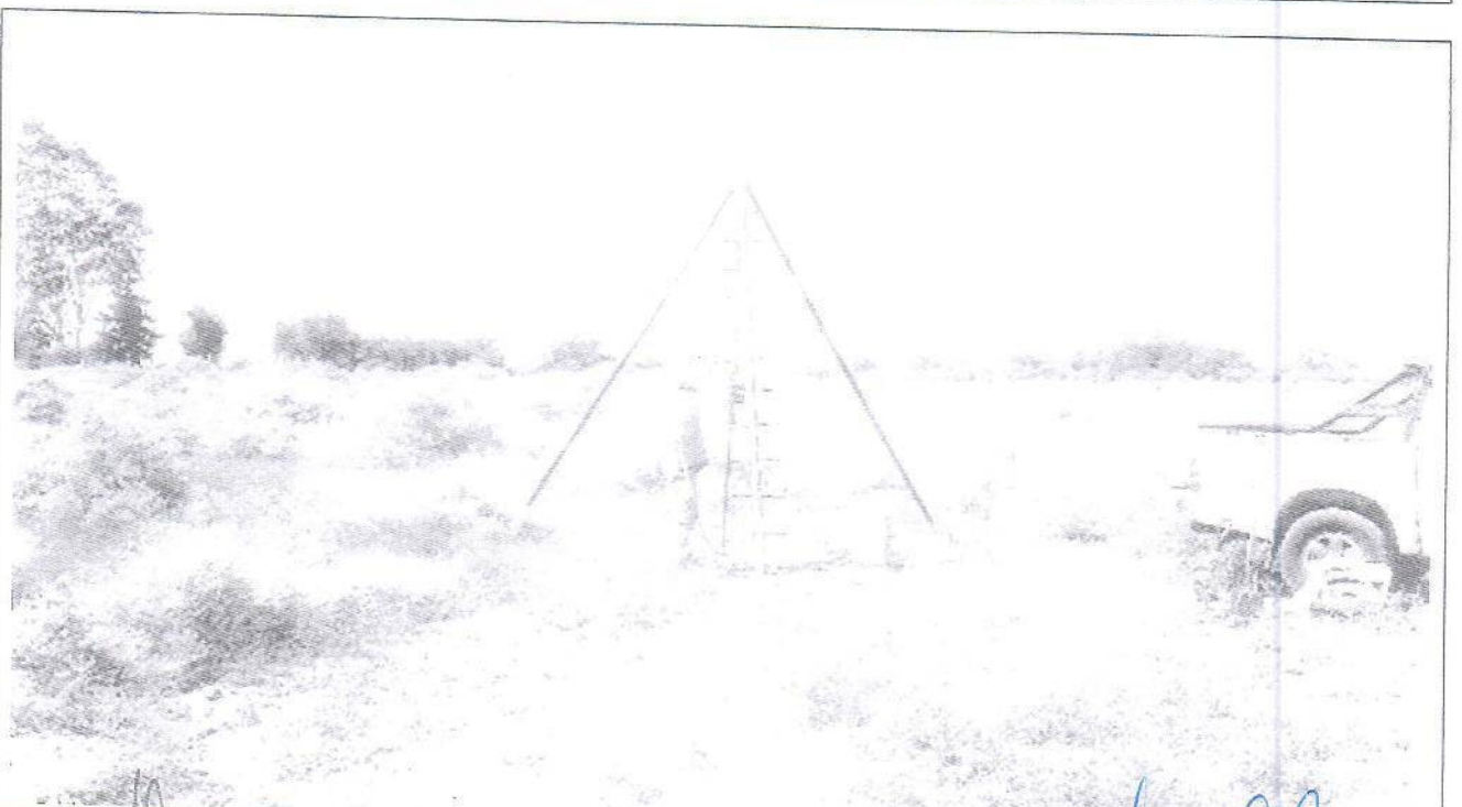
Fotografía N°8: Vista de la posición en el terreno del Sondeo S.1. Se observan los trabajos de perforación y toma de muestra, como así también el ensayo de penetración estándar (SPT).
