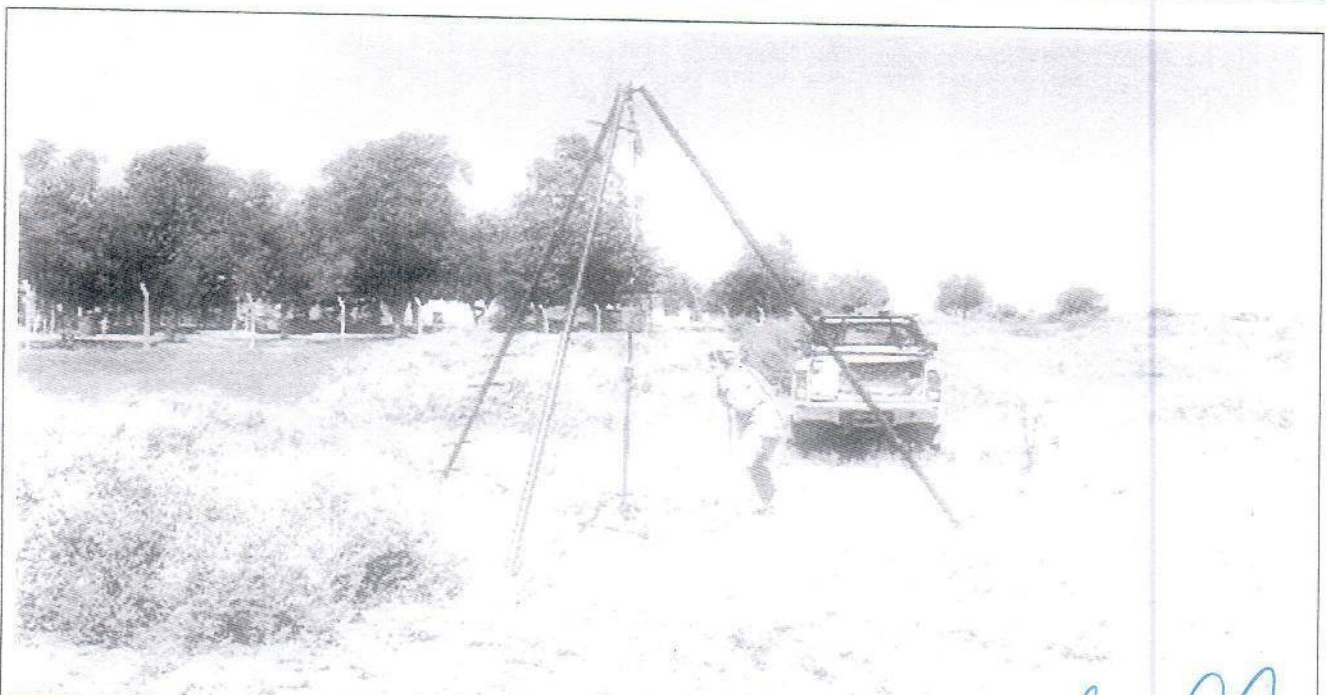
Fotografía N°20: Vista de la posición en el terreno del Sondeo S.4. Se observan los trabajos de perforación y toma de muestra, como así también el ensayo de penetración estándar (SPT).
