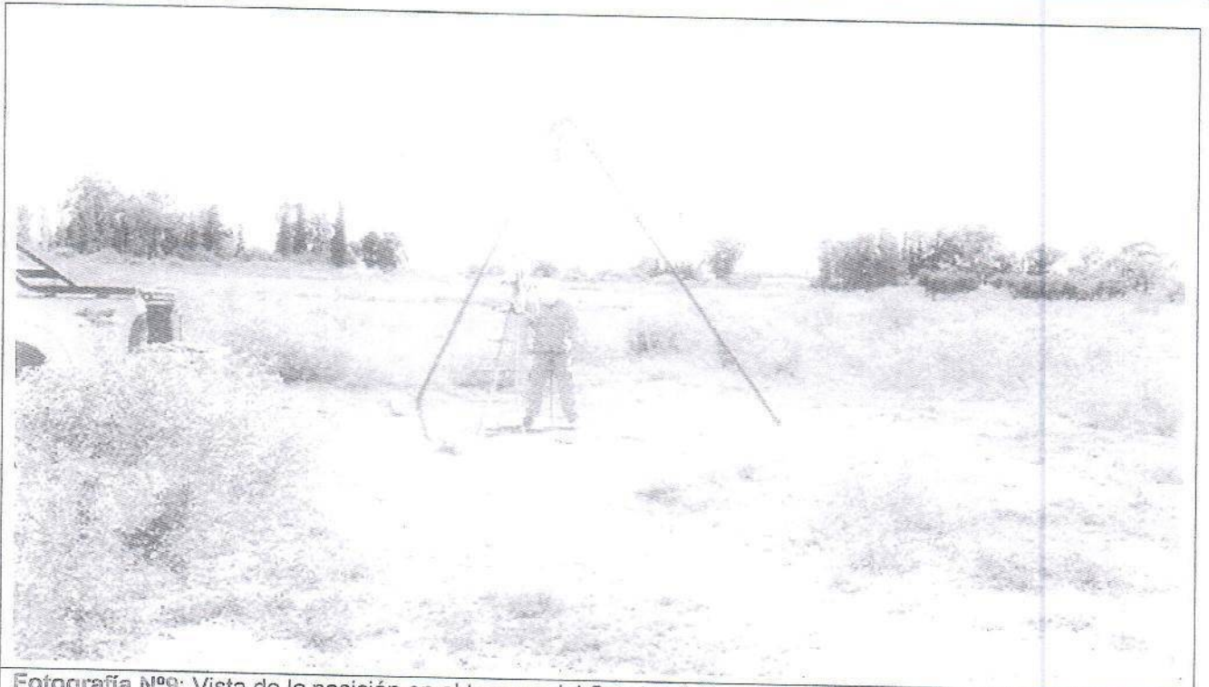
Fotografía N°9: Vista de la posición en el terreno del Sondeo S.2. Se observan los trabajos de perforación y toma de muestra, como así también el ensayo de penetración estándar (SPT).
