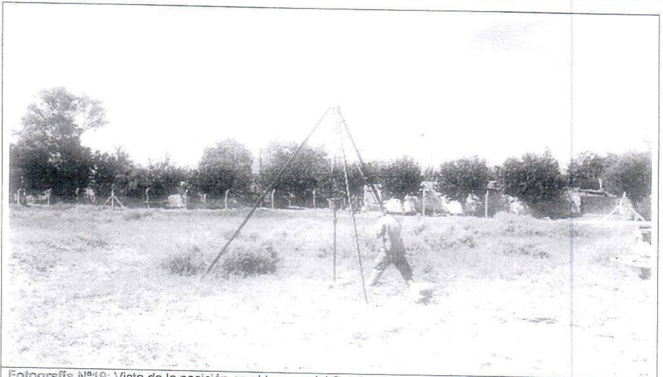
Fotografía N°19: Vista de la posición en el terreno del Sondeo S.4. Se observan los trabajos de perforación y toma de muestra, como así también el ensayo de penetración estándar (SPT).
