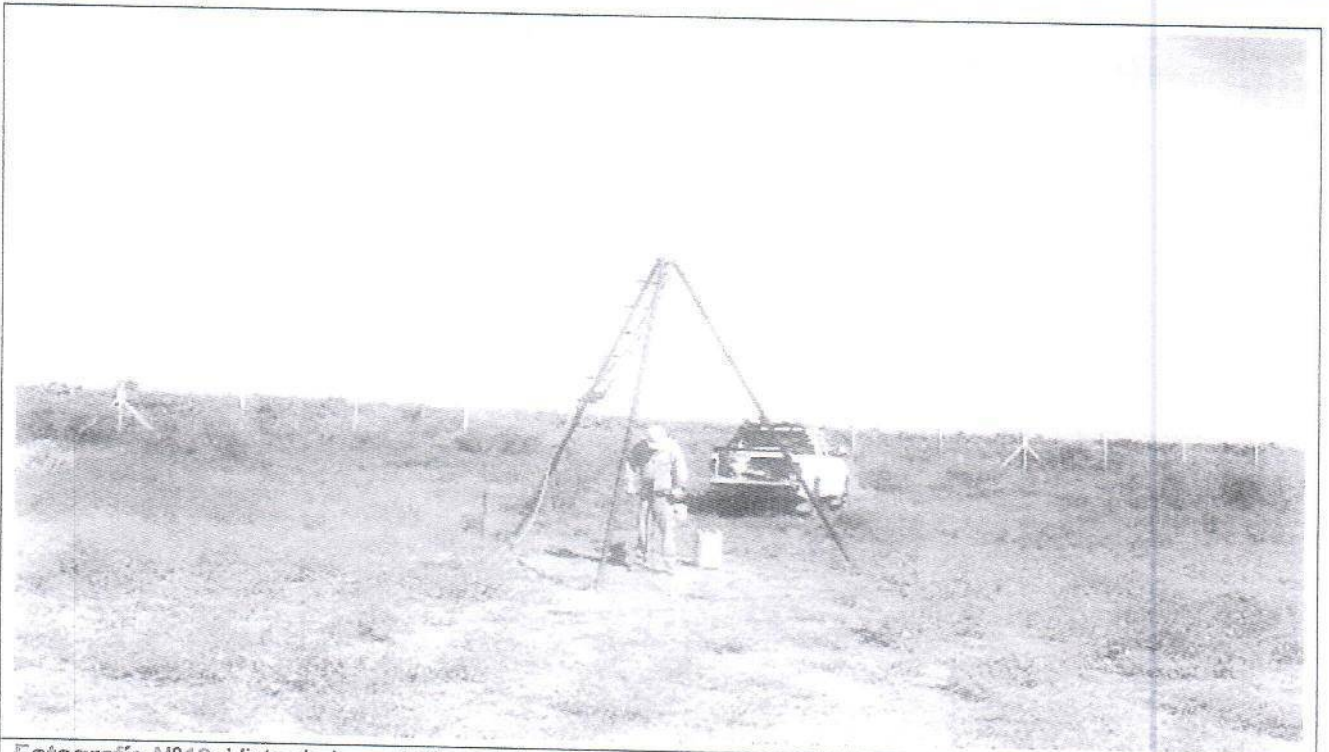
Fotografía N°13: Vista de la posición en el terreno del Sondeo S.3. Se observan los trabajos de perforación y toma de muestra, como así también el ensayo de penetración estándar (SPT).
