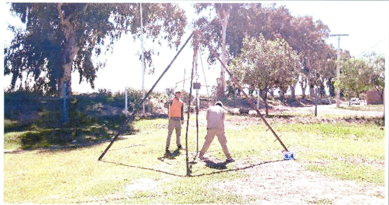
Fotografía N°17: Vista de la posición en el terreno del Sondeo S.4. Se observan los trabajos de perforación y toma de muestra.
