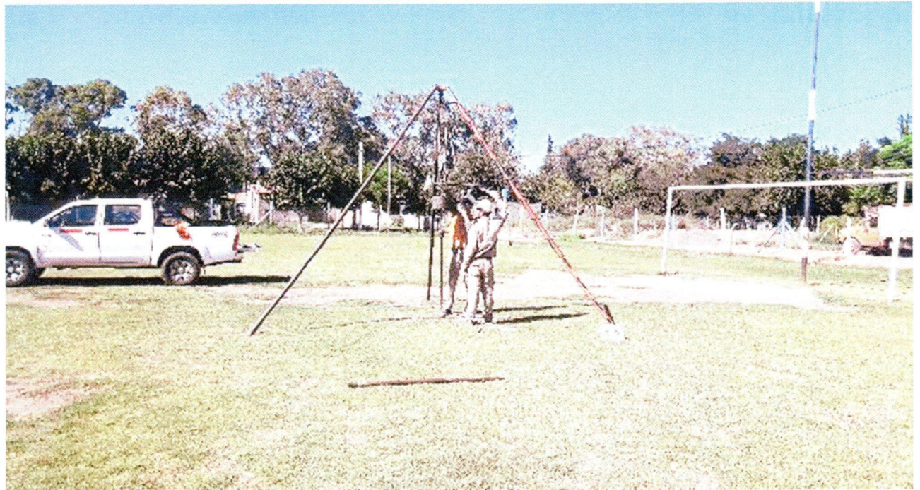
Fotografía N°11: Vista de la posición en el terreno del Sondeo S.3. Se observan los trabajos de perforación y toma de muestra, como así también el ensayo de penetración estándar (SPT).
