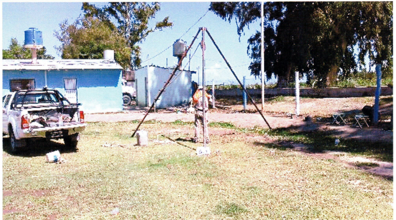
Fotografía N°5: Vista de la posición en el terreno del Sondeo S.1 . Se observan los trabajos de perforación y toma de muestra, como así también el ensayo de penetración estándar (SPT).
