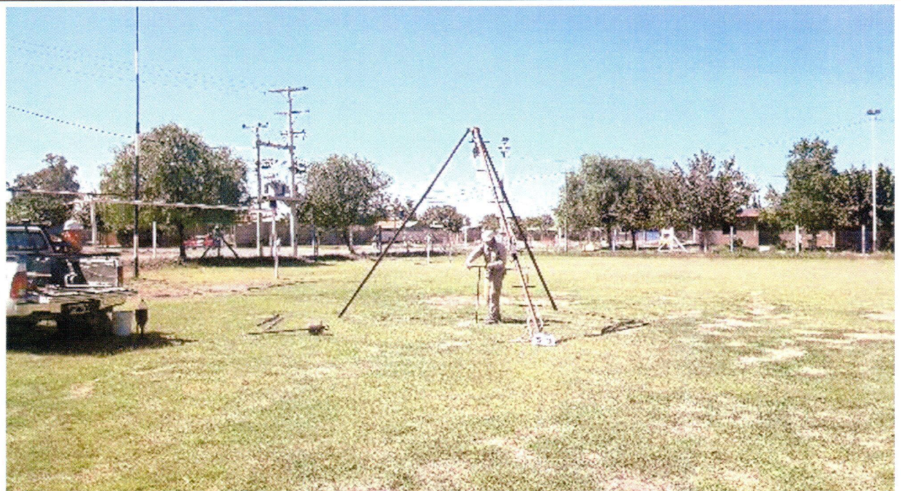
Fotografía N°12: Vista de la posición en el terreno del Sondeo S.3. Se observan los trabajos de perforación y toma de muestra, como así también el ensayo de penetración estándar (SPT).
