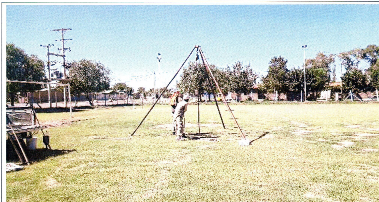
Fotografía N°14: Vista de la posición en el terreno del Sondeo S.3. Se observan los trabajos de perforación y toma de muestra.
