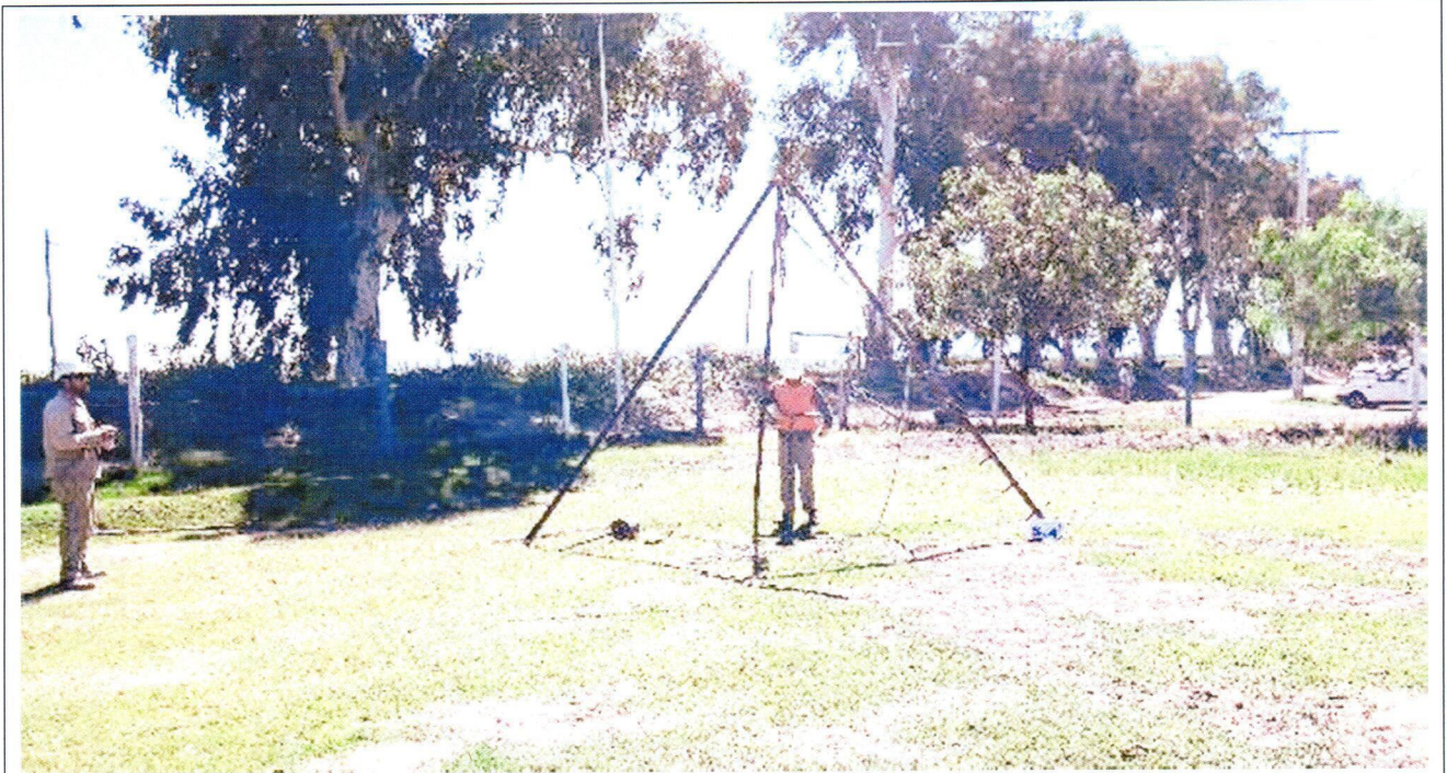
Fotografía N°15: Vista de la posición en el terreno del Sondeo S.4. Se observan los trabajos de perforación y toma de muestra.
