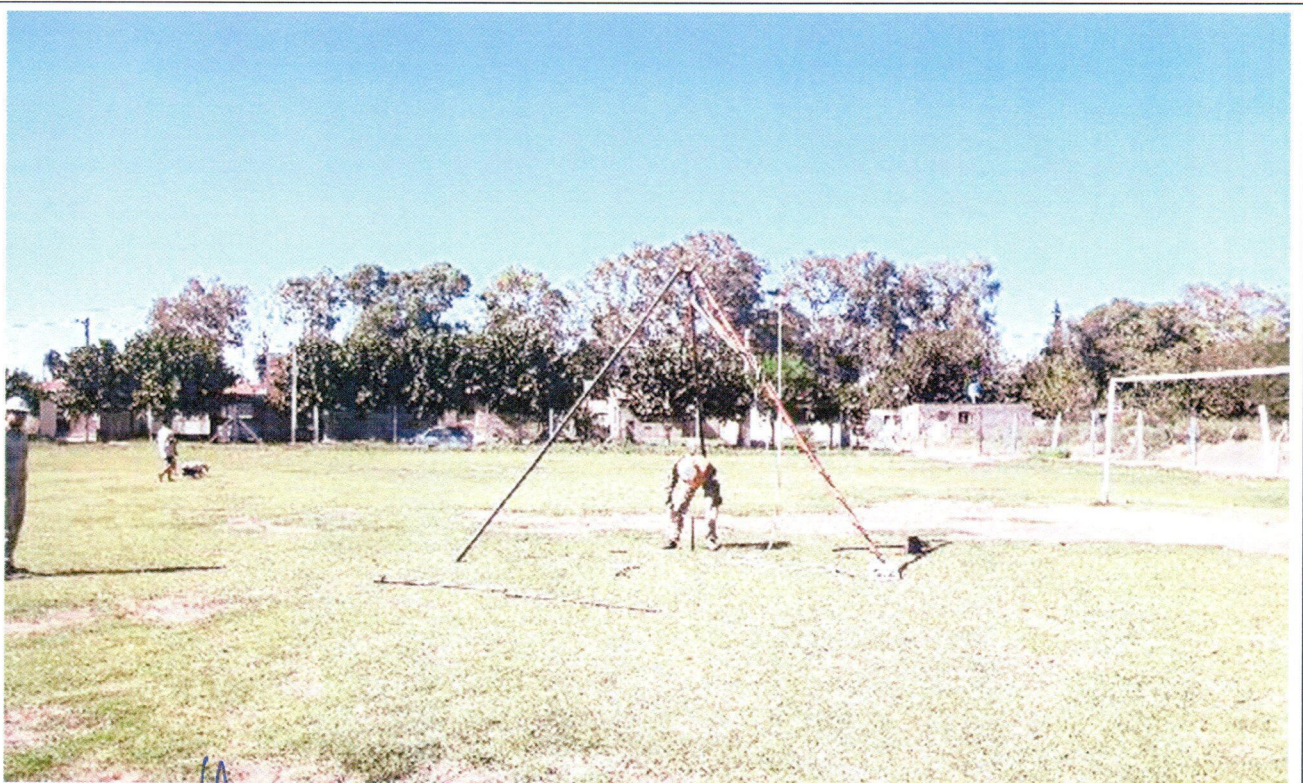
Fotografía N°10: Vista de la posición en el terreno del Sondeo S.2 . Se observan los trabajos de perforación y toma de muestra, como así también el ensayo de penetración estándar (SPT).
