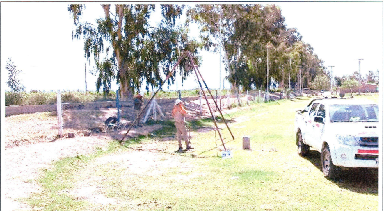
Fotografía N°6: Vista de la posición en el terreno del Sondeo S.1 . Se observan los trabajos de perforación y toma de muestra, como así también el ensayo de penetración estándar (SPT).
