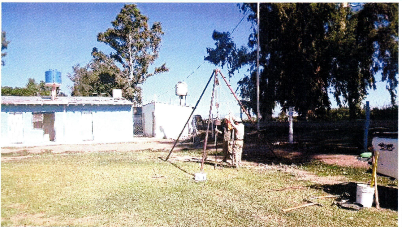
Fotografía N°8: Vista de la posición en el terreno del Sondeo S.1 . Se observan los trabajos de perforación y toma de muestra, como así también el ensayo de penetración estándar (SPT).
