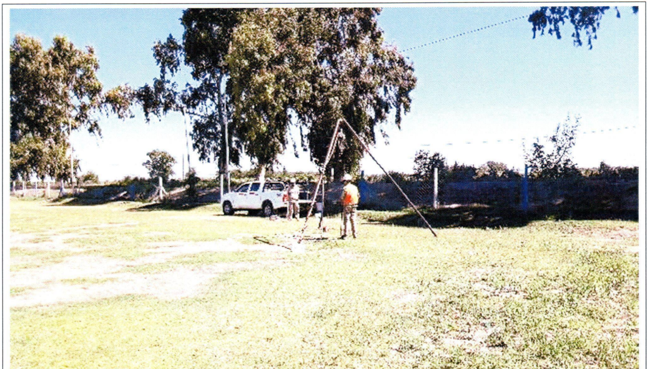
Fotografía N°16: Vista de la posición en el terreno del Sondeo S.4. Se observan los trabajos de perforación y toma de muestra.
