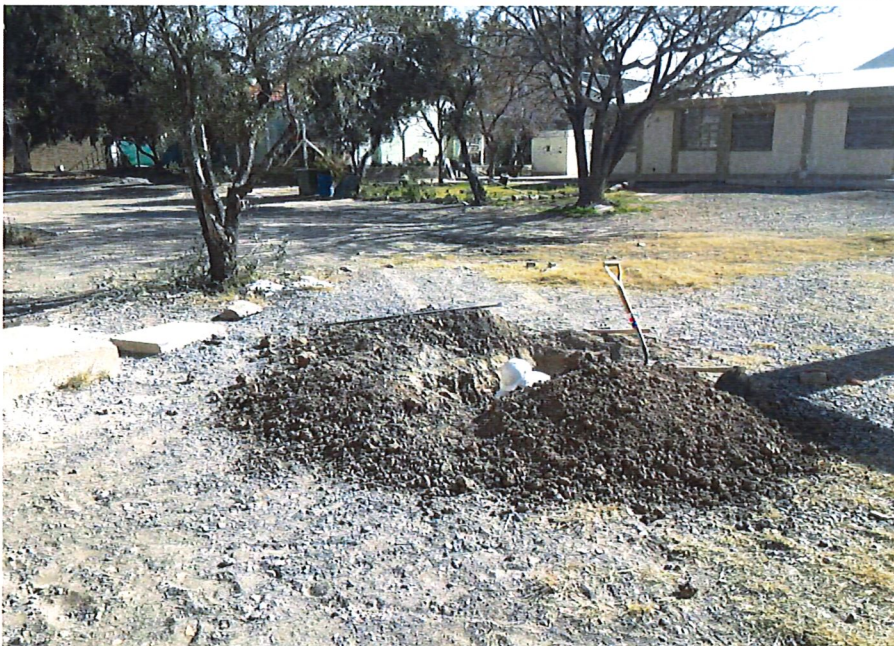
Fotografía N°13: Vista de la posición de la calicata C.2 en el terreno estudiado, se observan los trabajos de excavación.
