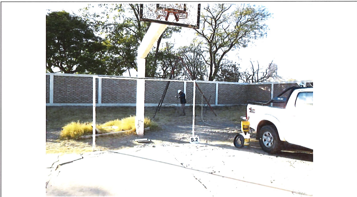
Fotografía N°18: Sondeo S.2. Se observa la posición en el terreno del mismo, y los trabajos de perforación y toma de muestra, como así también el ensayo de penetración estándar (SPT).
