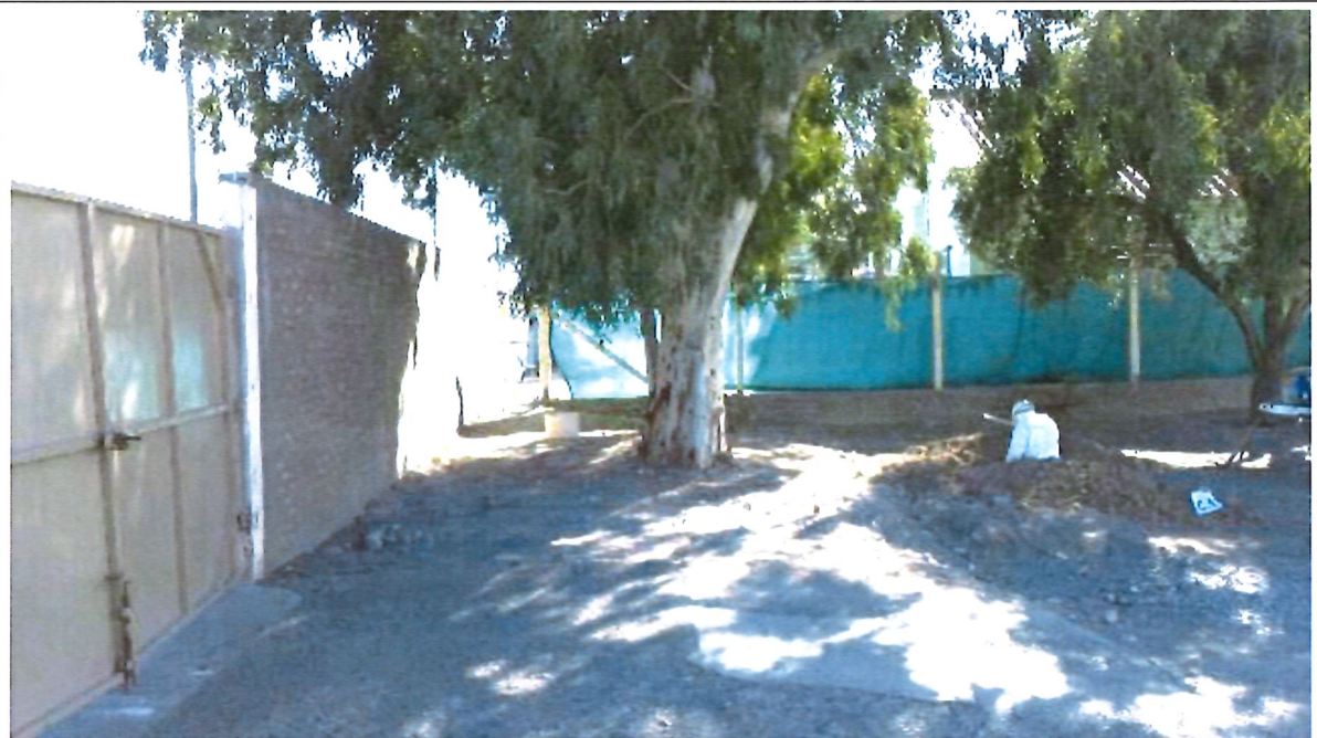
Fotografía N°4: Vista de la posición de la calicata C.1 en el terreno estudiado, se observan los trabajos de excavación.
