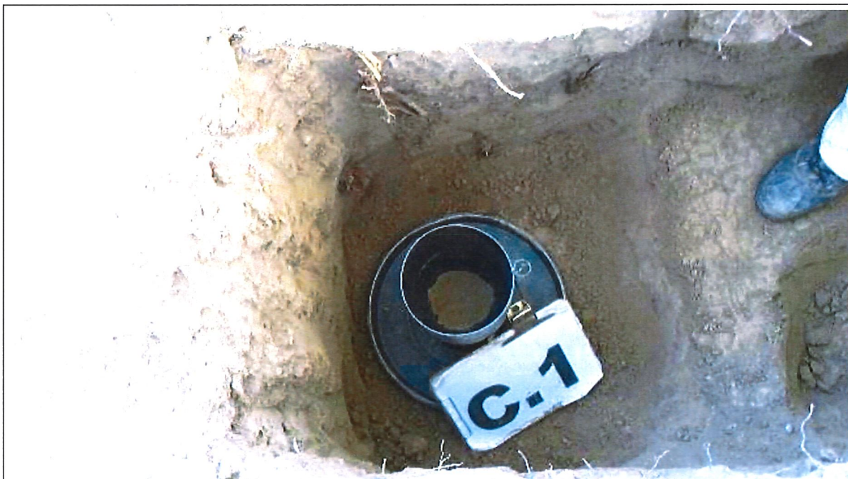
Fotografía N°6: Calicata C.1, se observa el ensayo de densidad in situ a la Prof. de 1,00m, en el estrato superior de limo arenoso.
