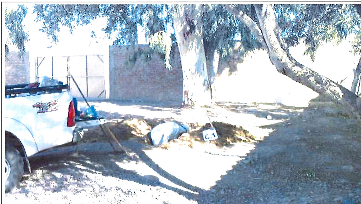
Fotografía N°5: Vista de la posición de la calicata C.1 en el terreno estudiado, se observan los trabajos de excavación.
