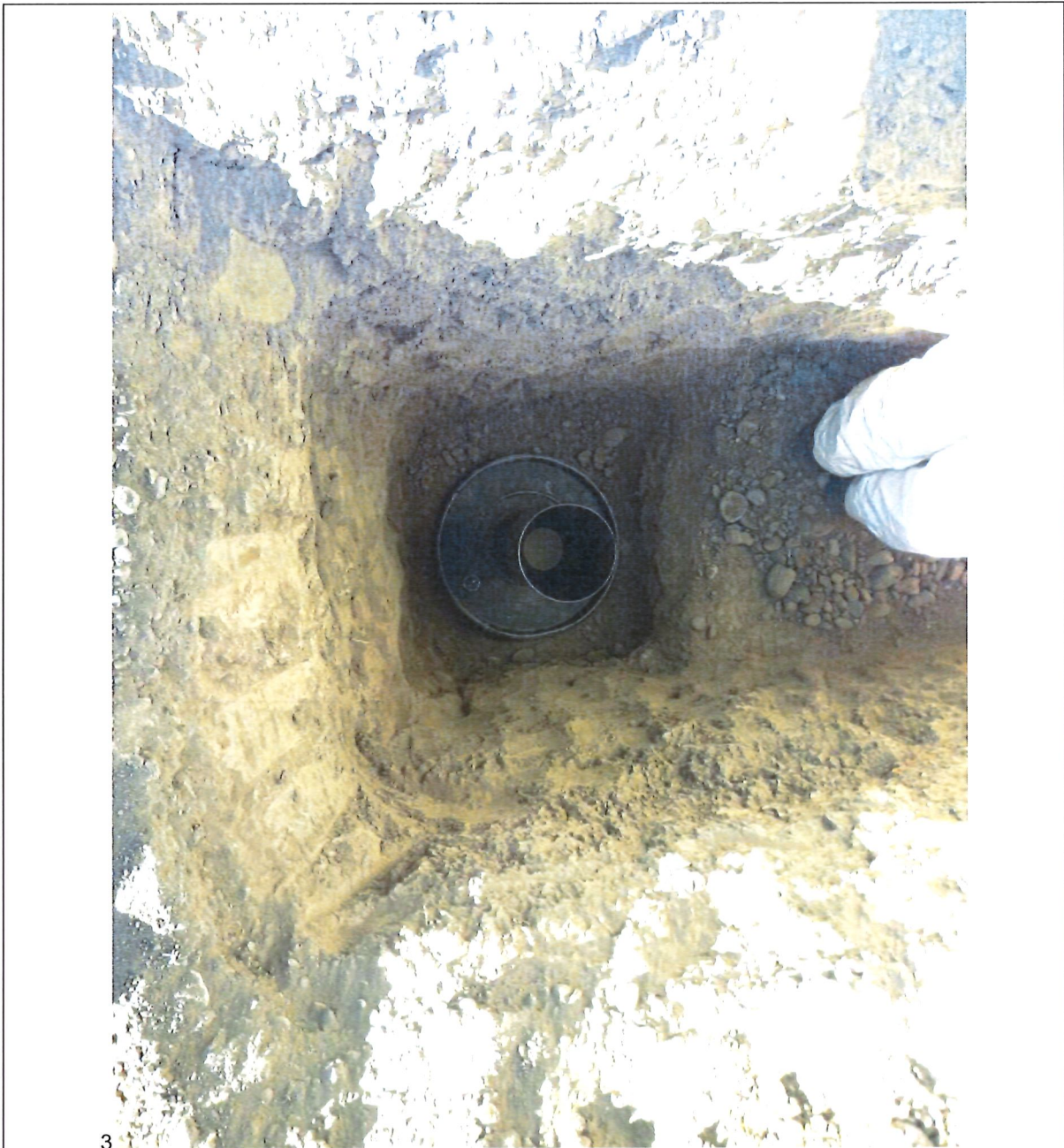
Fotografía N°14: Se muestra la excavación de la calicata C.2, observando el perfil estratigráfico de suelos compuesto formado por un relleno superior de 1,00m, le continúa el primer estrato de suelo natural de limo arenoso y subyacente a la profundidad de 1,50m el comienzo del segundo estrato granular grueso formado por gravas limpias. Se observa el ensayo de densidad in situ a la Prof. de 1,80m en el estrato subyacente de grava arenosas.
