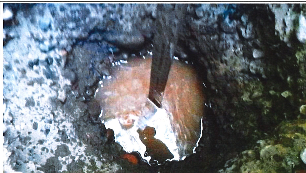
Fotografía N°9: Calicata C.1. Se muestra el ensayo de infiltración a la profundidad de 1,80m en el estrato de gravas aluviales.
