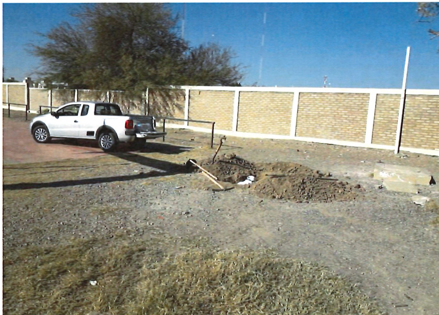
Fotografía N°11: Vista de la posición de la calicata C.2 en el terreno estudiado, se observan los trabajos de excavación.
