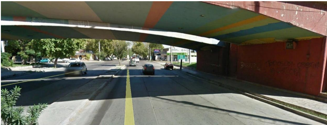
Puente Avenida Libertador San Martín y Avenida de Circunvalación al Oeste.
