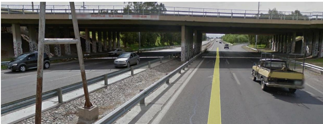
Puente Avenida de Circunvalación y Avenida Rawson al Norte.
