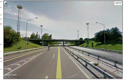
Vista Lateral de Puente en Calle A. Tapia
