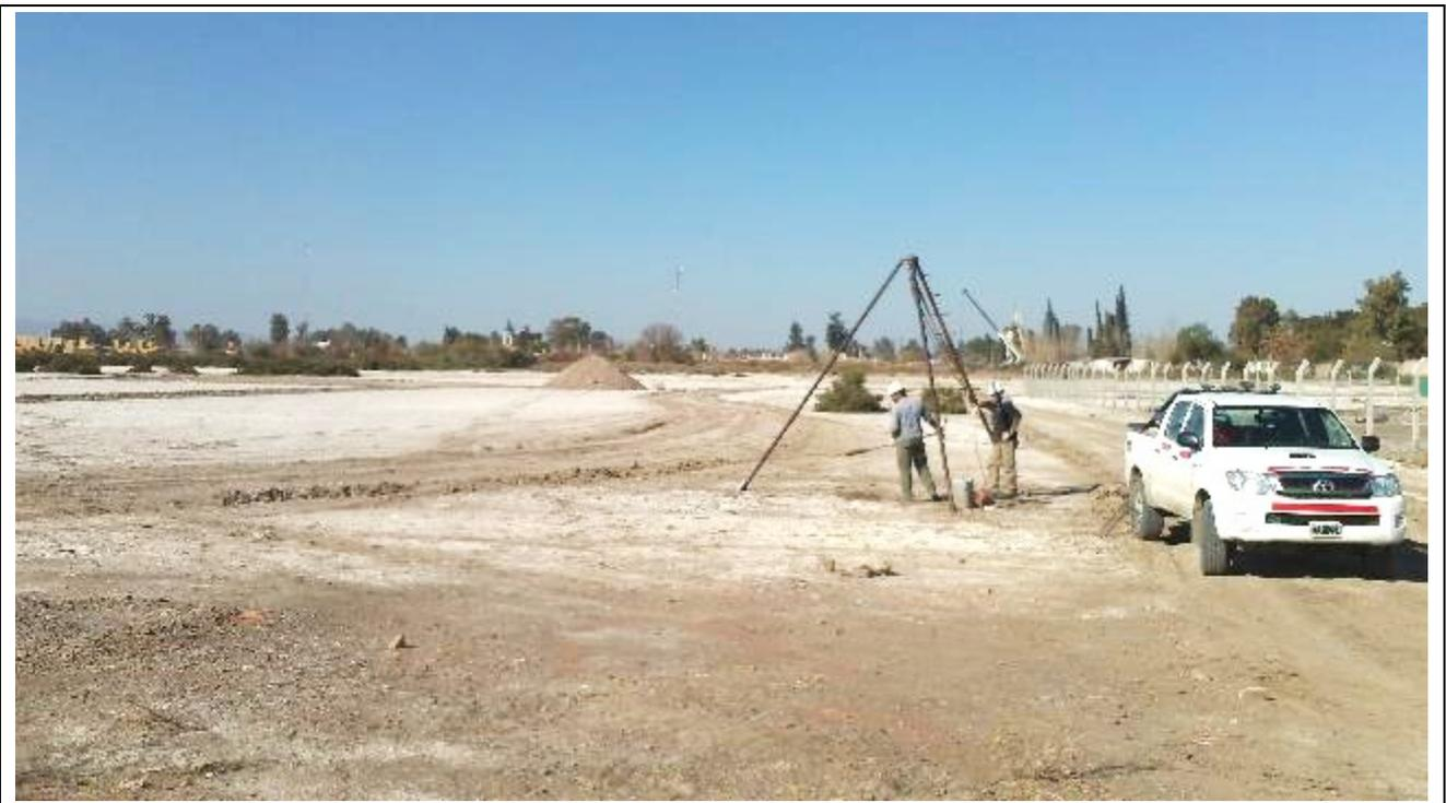
**Fotografía N°3:** Vista de la posición en el terreno del Sondeo **S.1**. Se observan los trabajos de perforación y toma de muestra, como así también el ensayo de penetración estándar (SPT).
