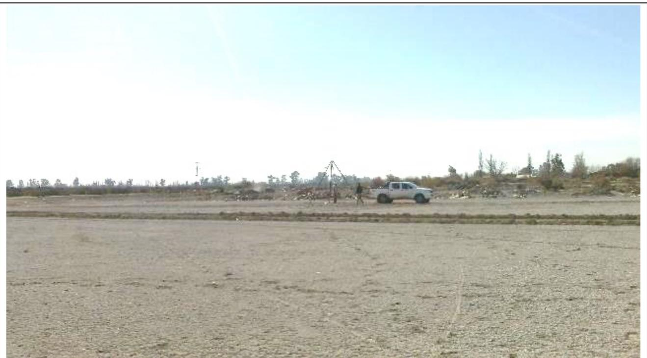
**Fotografía N°6:** Vista de la posición en el terreno del Sondeo **S.2**. Se observan los trabajos de perforación y toma de muestra, como así también el ensayo de penetración estándar (SPT).
