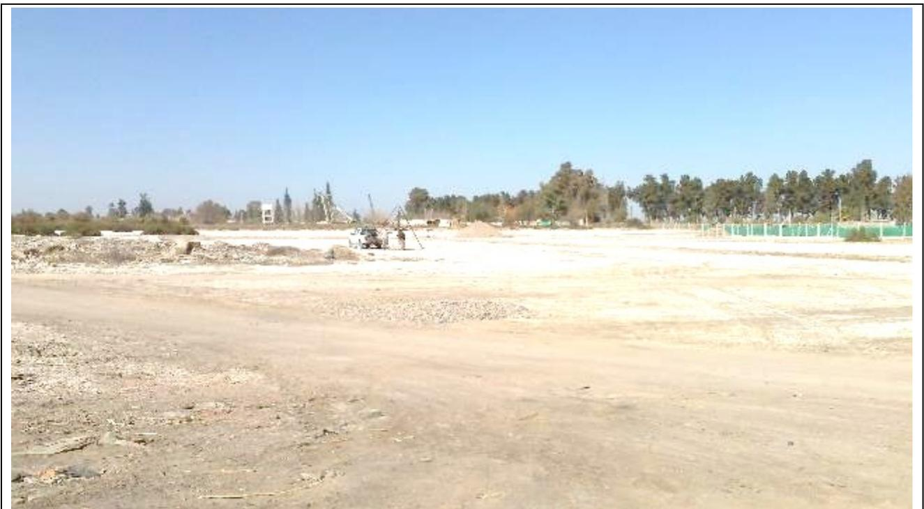
**Fotografía N°8:** Vista de la posición en el terreno del Sondeo **S.2**. Se observan los trabajos de perforación y toma de muestra, como así también el ensayo de penetración estándar (SPT).
