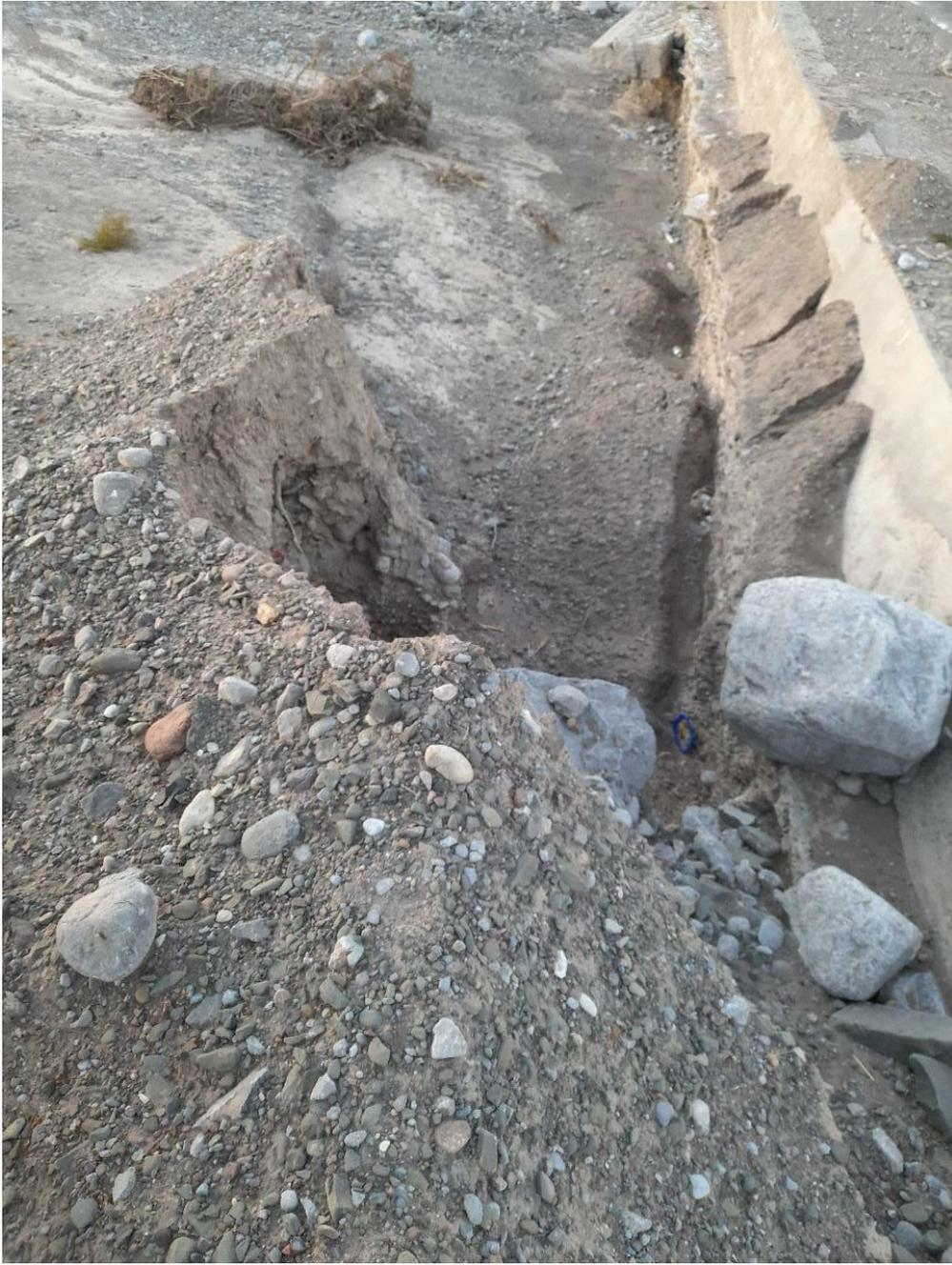
*Foto: Badén N°2 Socavación Aguas- Abajo.*
