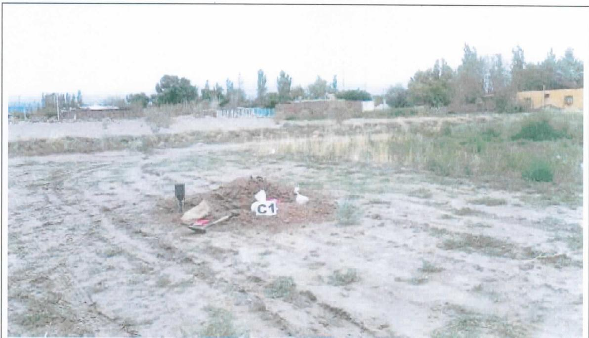
**Foto N°4:** Se muestra la posición de la calicata C.1 en el terreno estudiado, y los trabajos de excavación y toma de muestra.
