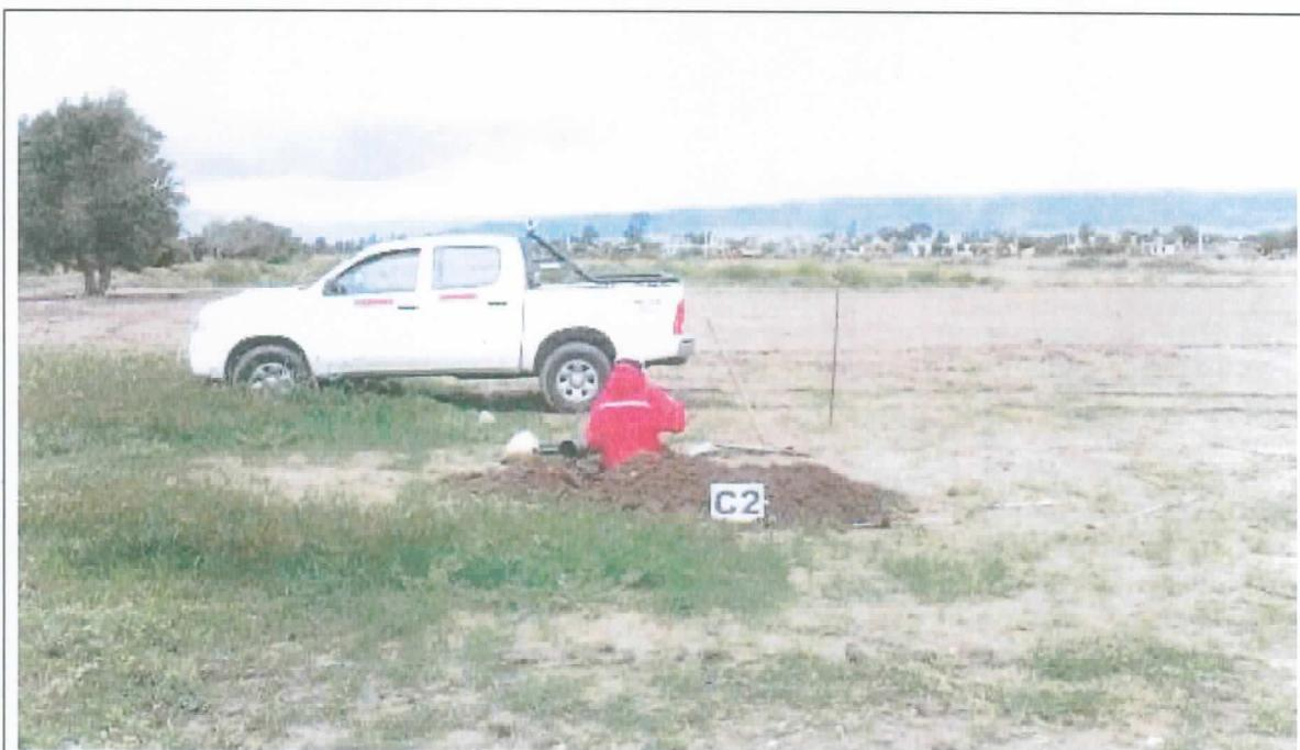
**Foto N°6:** Se muestra la posición de la calicata C.2 en el terreno estudiado, y los trabajos de excavación y toma de muestra.
