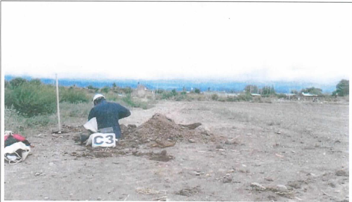
**Foto N°7:** Se muestra la posición de la calicata C.3 en el terreno estudiado, y los trabajos de excavación y toma de muestra.
