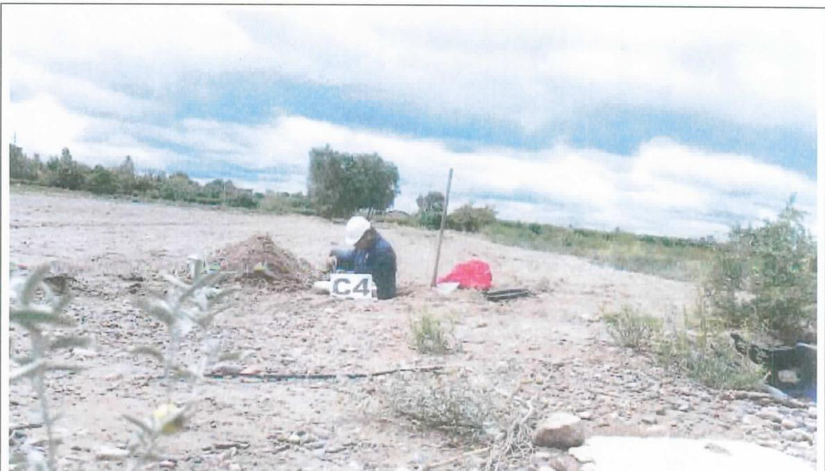
**Foto N°8:** Se muestra la posición de la calicata C.4 en el terreno estudiado, y los trabajos de excavación y toma de muestra.
